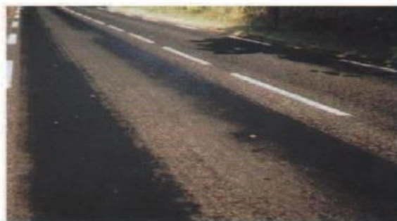
Figura 4 Falla tipo exudación
