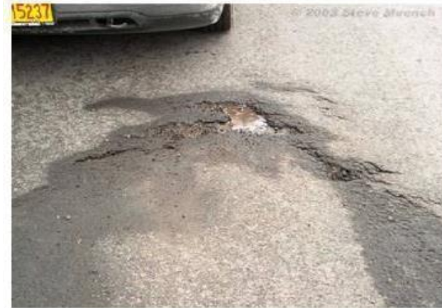
Figura 21 Falla por grietas parabólicas
