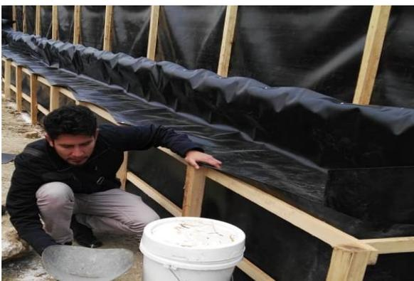
Camas composteras impermeabilizadas con geomembrana
