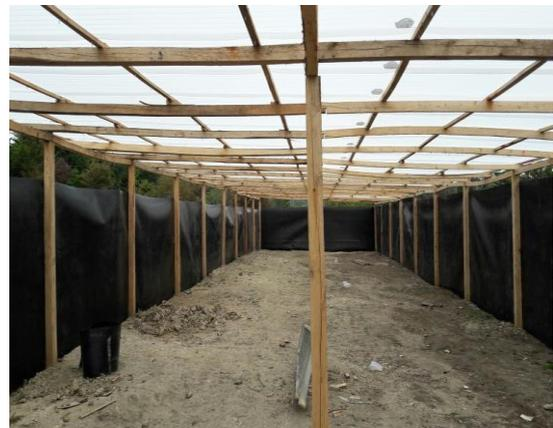
Planta de Compostaje rodeada con geomembrana y techo de calamina Blanca
