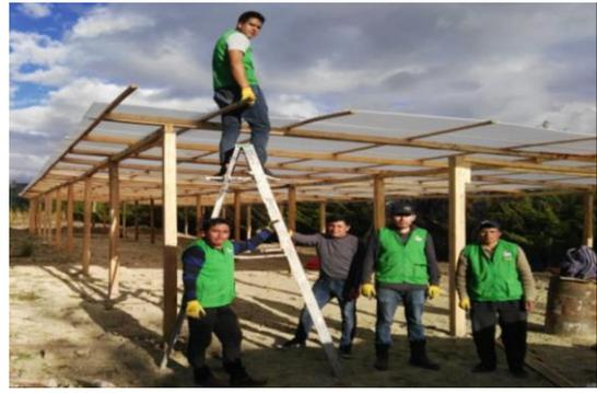
Armado del esqueleto de la planta con madera y colocación del techo con calamina blanca
