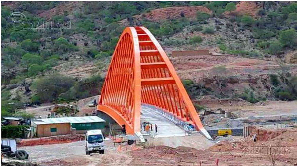
Fuente: Prensa Pataz Informa; Puente Antonio Raimondi
