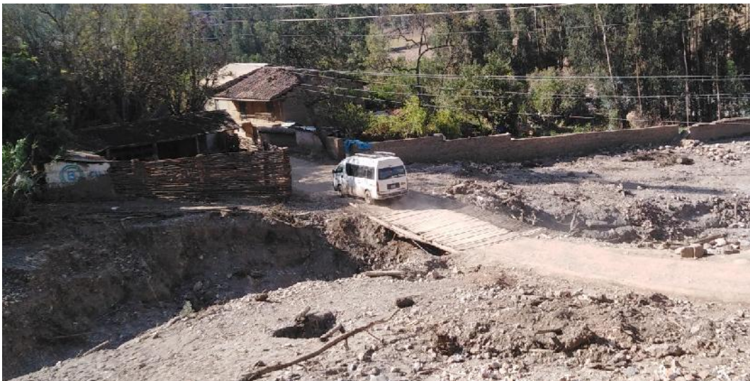
Foto 06: Puente provisional construido por la Municipalidad Provincial de Pomabamba en la zona a intervenir.
