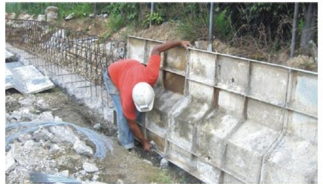
4.- Fijación y aseguramiento de las formaletas
