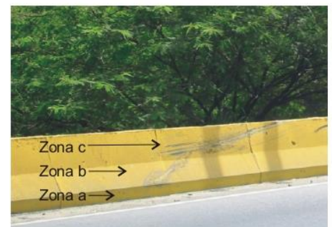
Foto 2 Mecanismo de funcionamiento de una barrera de seguridad de concreto durante un impacto vehicular
