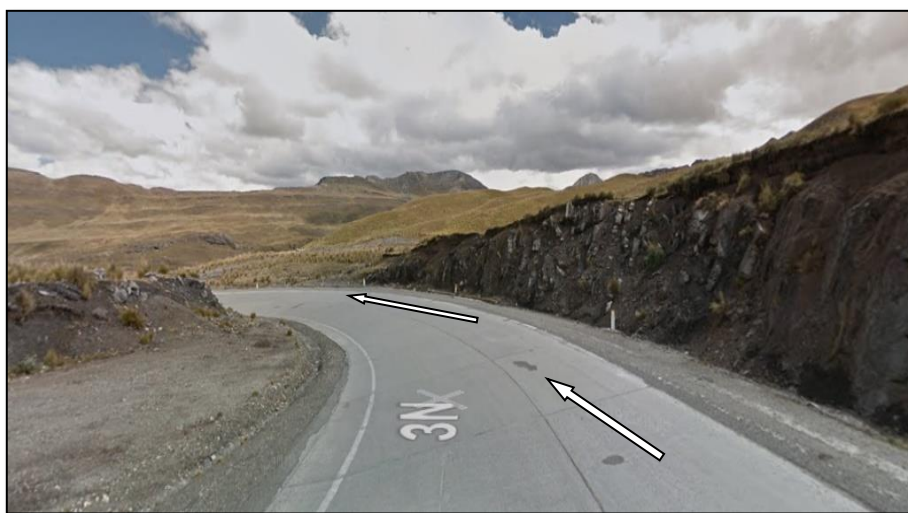
Figura 3. Progresivas del Km 57+400, Posición de la carretera antes de la curva.
