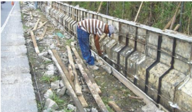
5.- Listo para el vaciado del concreto
