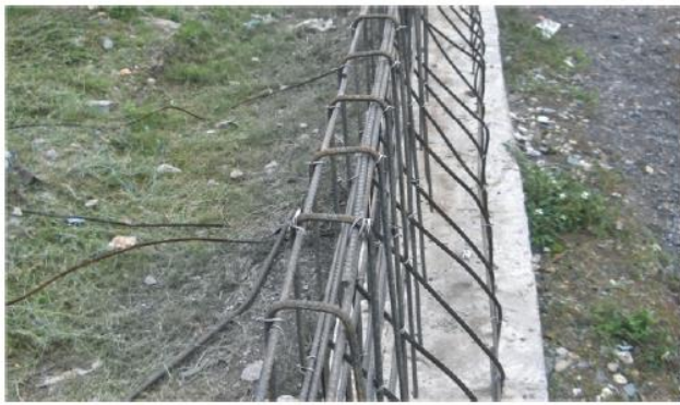
1.- Acero de refuerzo
