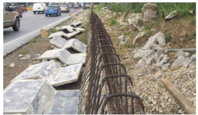
2.- Preparación de las formaletas del encofrado
