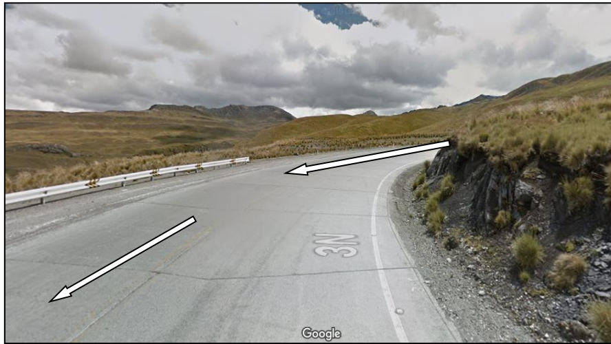
Figura 4. Progresivas del Km 57+350, Posición de la carretera después de la curva.
