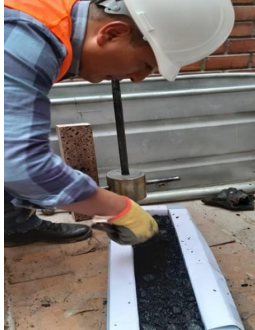
Figura N° 75: Proceso de compactación de la mezcla asfáltica.
