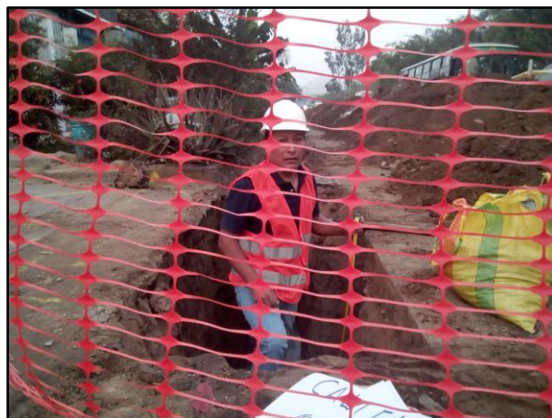
Figura N° 43: Excavación de la Muestra 2
