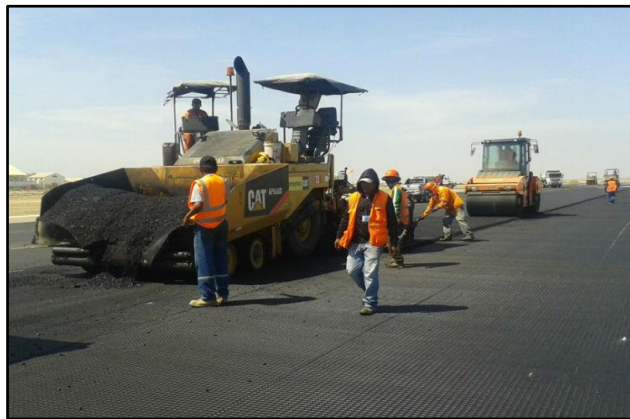
Figura N° 30: Mantenimiento periódico del pavimento
