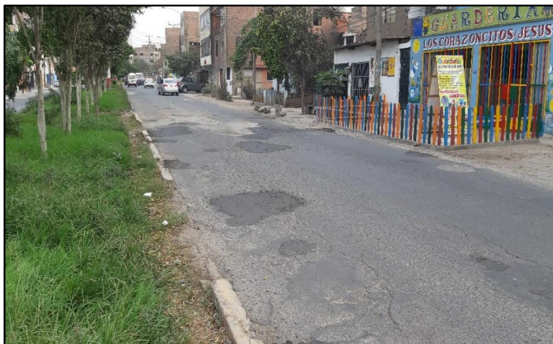
Figura N° 41: Parcheo del pavimento
