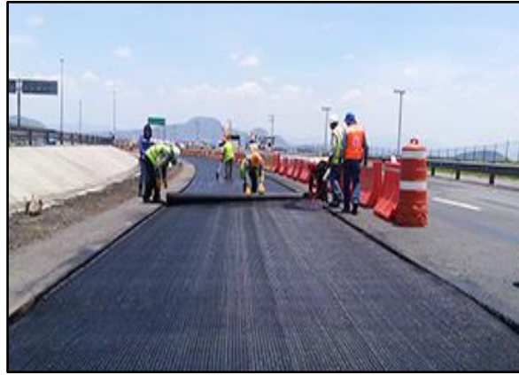
Figura N° 10: Geomalla fibra de vidrio en proceso constructivo del pavimento.
