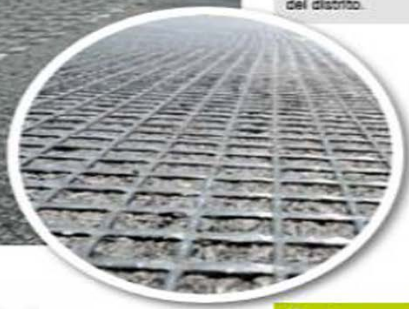
Pavimento cuenta con moderna técnica de Geomalla Biaxial.
