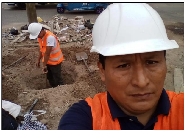
Figura N° 44: Excavación de la Muestra 3
