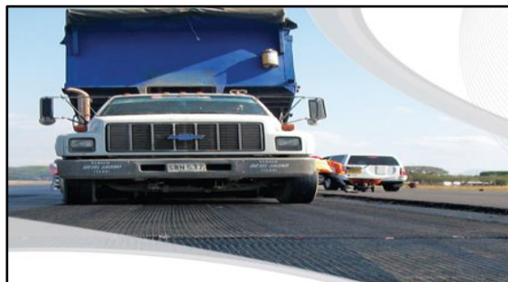
Figura N° 9: Incorporación de Geomalla fibra de vidrio.
