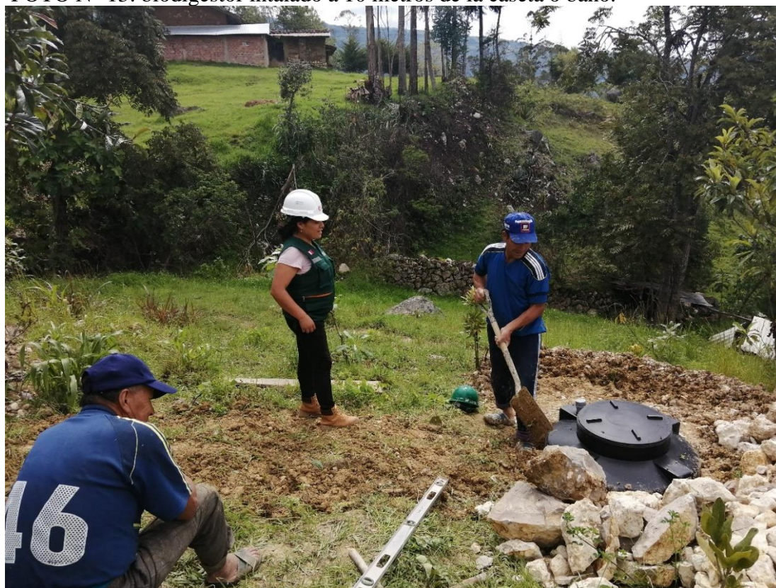
FOTO N° 13: biodigestor intalado a 10 metros de la caseta o baño.
