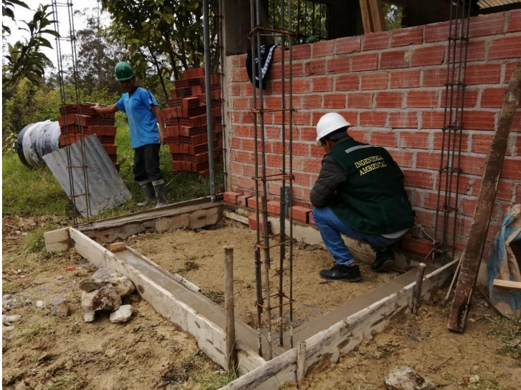
FOTO N° 10: construcción de la base para la caseta de la UBS.
