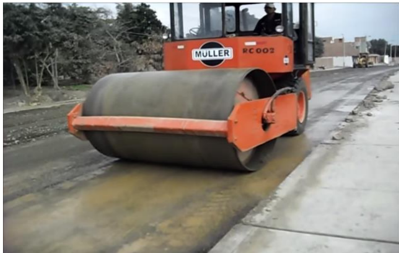
Figura 6. Pavimento de concreto asfáltico.
