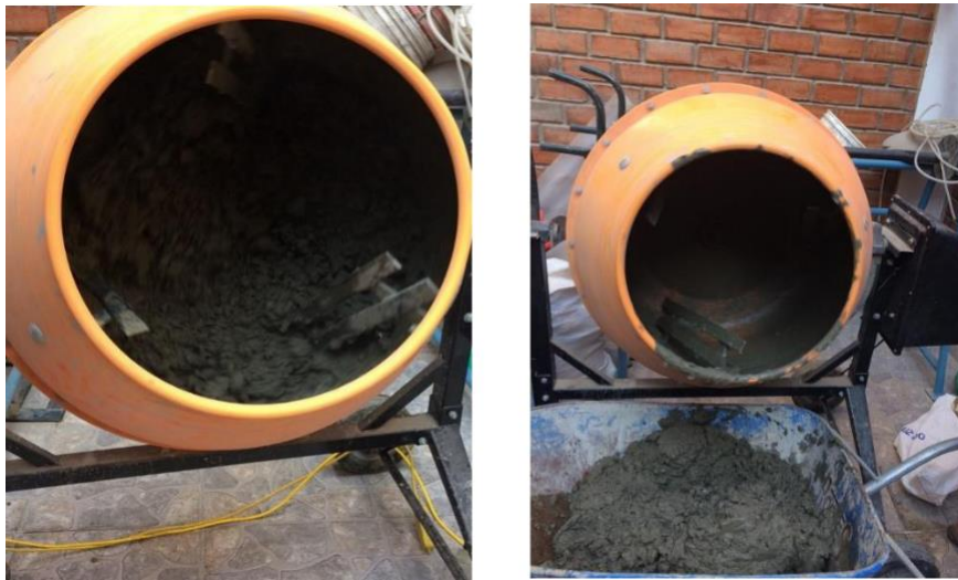
Figura 29. Mezcladora de la mezcla de concreto. Fuente: Elaboración Propia
