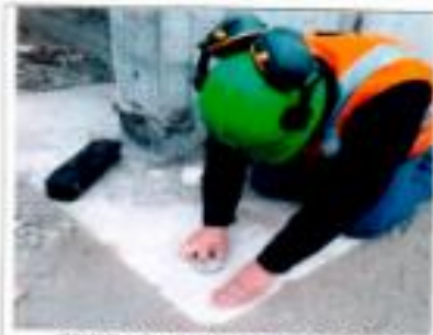
PREPARACION DE TERRENO
