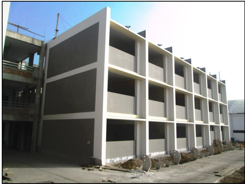
Figura 5. Módulo I, en I.E. 1182 El bosque –Lugar de la Mejoramiento de Columnas
