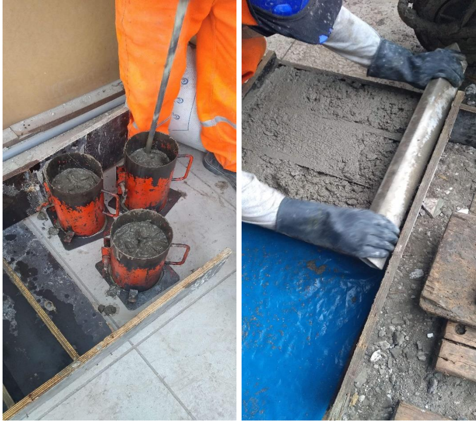
Figura 30: Vaciado de probetas cilíndricas y vigas Fuente: (propia)
