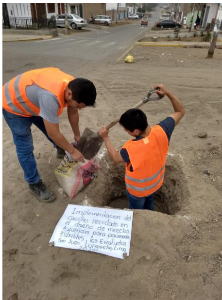
Figura 18. Muestra extraída (suelo). Fuente: Elaboración Propia
