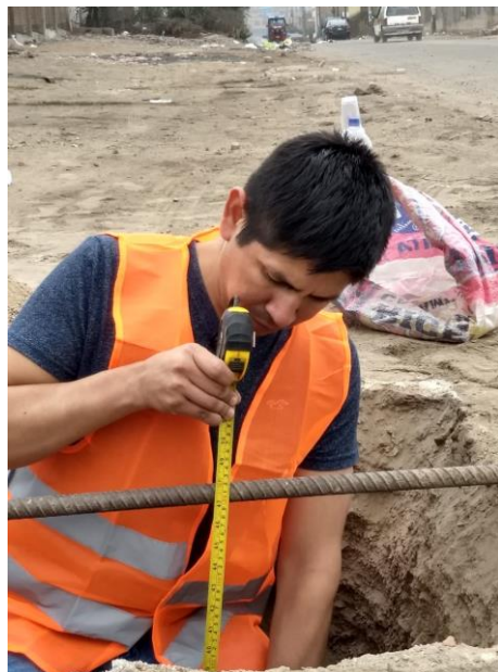
Figura 19. Dimensionamiento de la calicata
