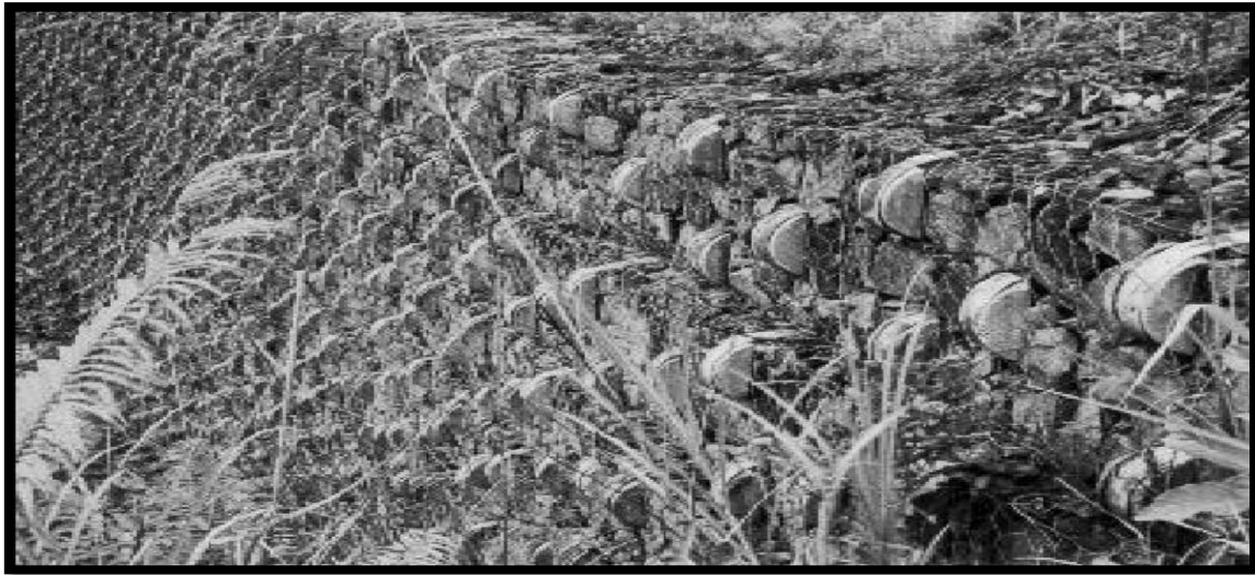
Figura 36: Sistema de Muro Terramesh
