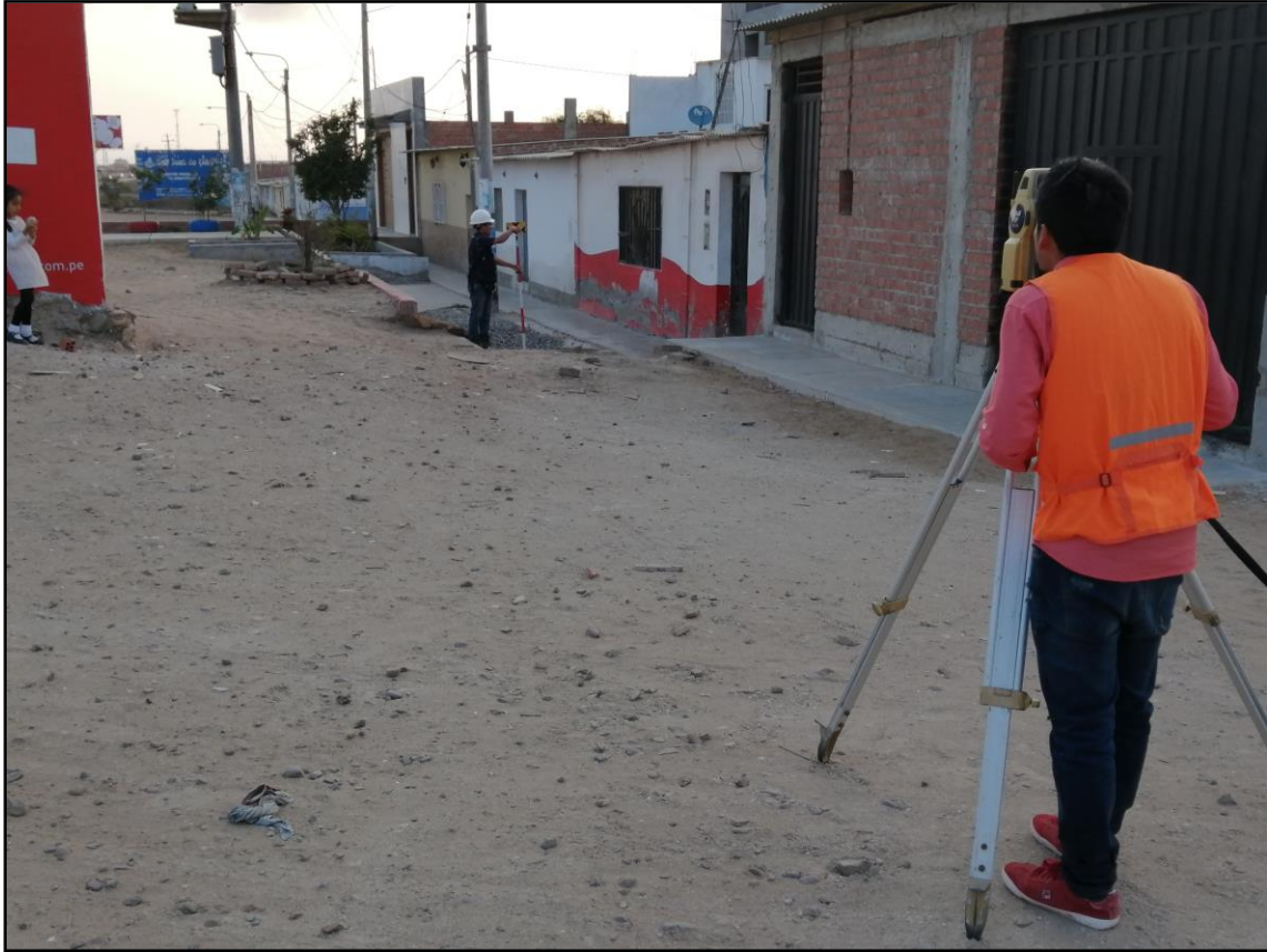
Foto N°07: Levantamiento Topográfico Autopista Pimentel - Chiclayo
