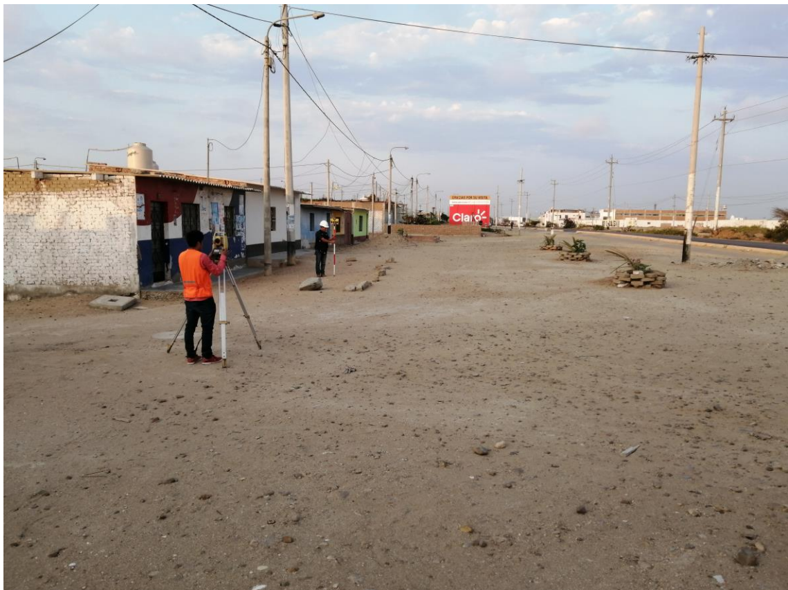
Foto N°06: Levantamiento Topográfico Autopista Pimentel - Chiclayo
