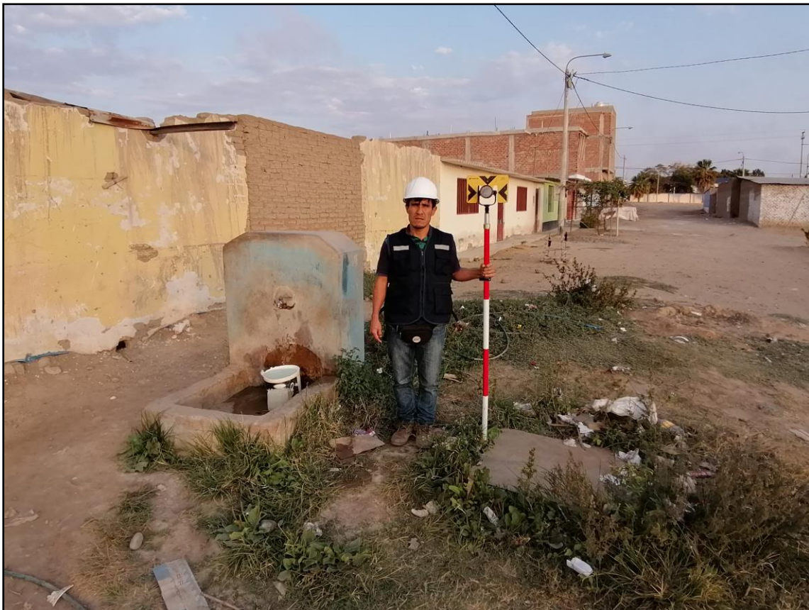
Foto N°04: Levantamiento Topográfico Calle Los Pinos
