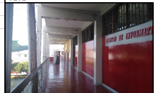
No se encuentra problemas en sus estructuras
