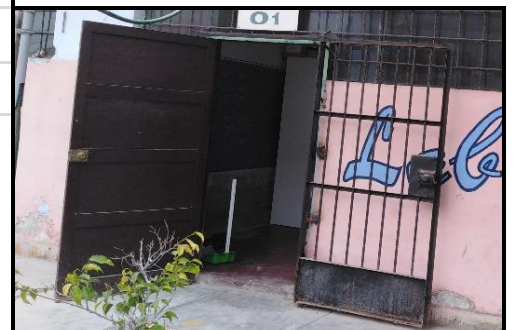
Por los equipos costosos que se tiene cuenta con dos puertas, una de fierro y otra de madera
