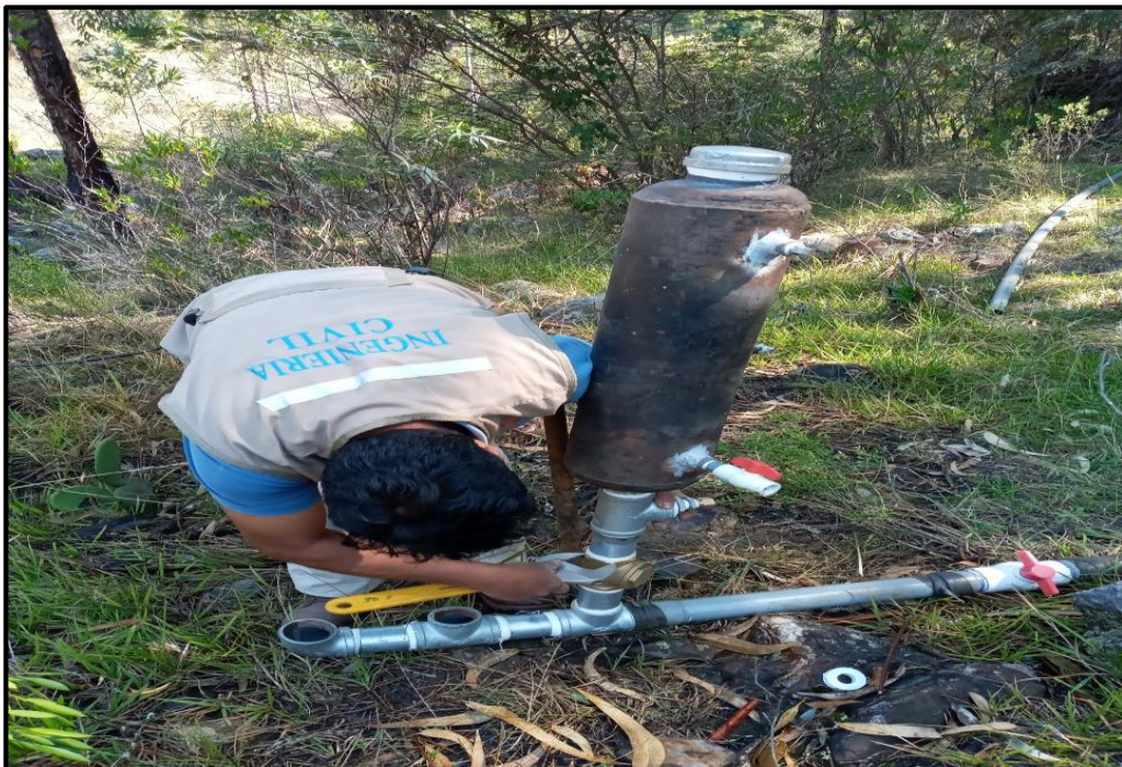
Fotografía 2. Instalación de la bomba ariete
