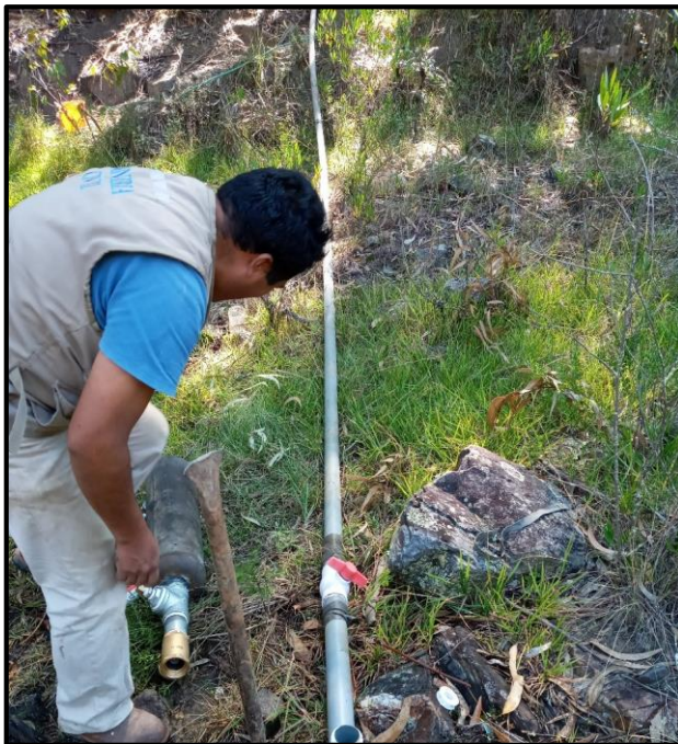
Fotografía 8. bomba de ariete hidráulico trabajando con las válvulas en serie.
