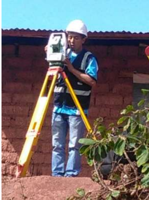
Fotografía N°05. Realizando el levantamiento topográfico de la localidad de la florida.
