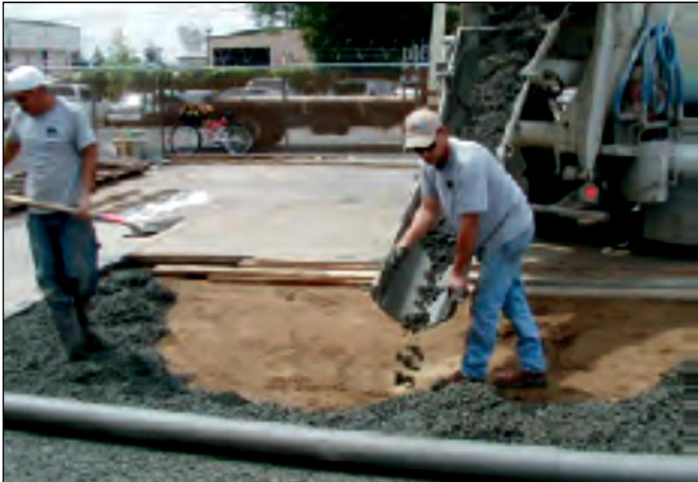
Figura N° 15: Colocación de concreto poroso
