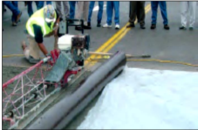
Figura N° 1734: Curado de concreto poroso
