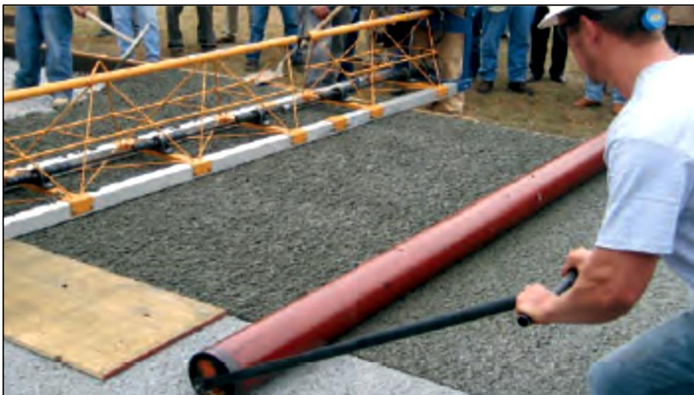
Figura N° 16: Compactación de concreto poroso
