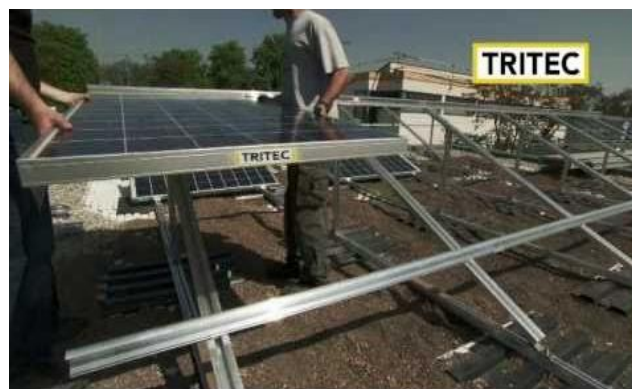
Figura 6. Estructuras de aluminio.
