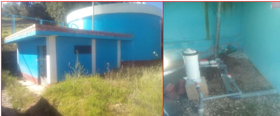
Figura 17: imagen del reservorio existente
