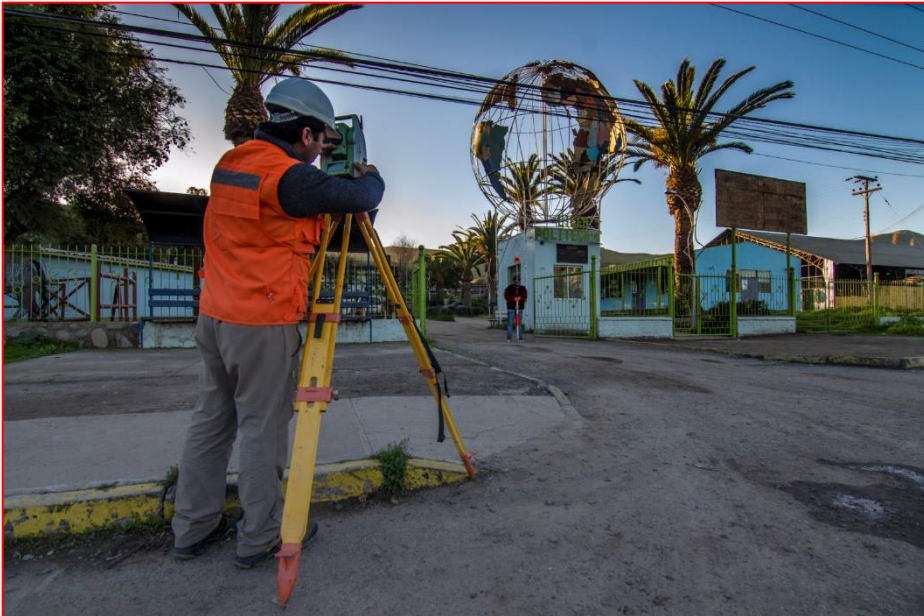
Fotografía 06: Levantamiento topográfico mediante la ayuda de estación, tomando puntos en la exteriores de la poblacion
