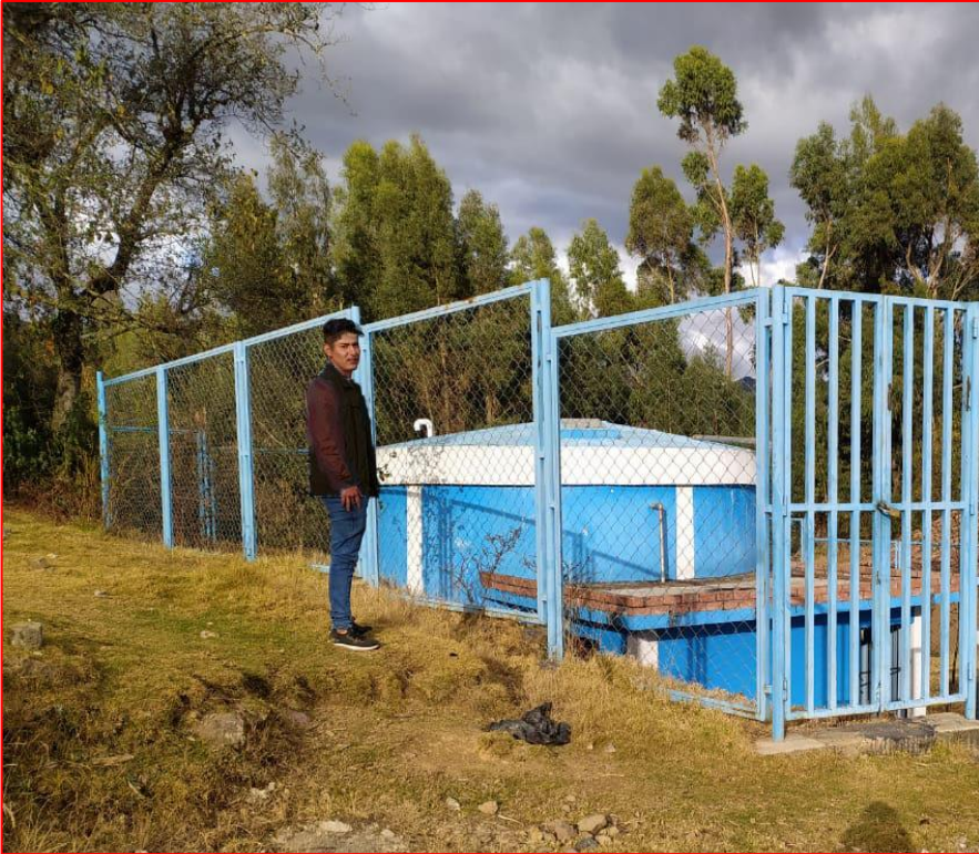
Fotografía 03: Reservorio existente, visita toma de datos
