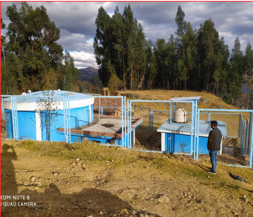
Fotografía 04: Reservorio existente, toma de datos topográficos
