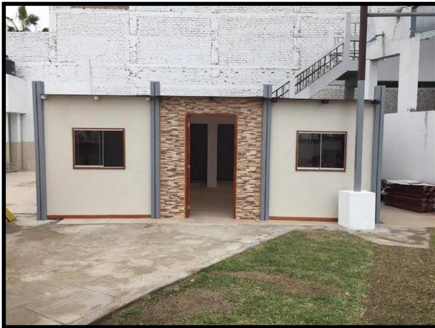
*Figura 10: Vivienda de concreto polimérico*
