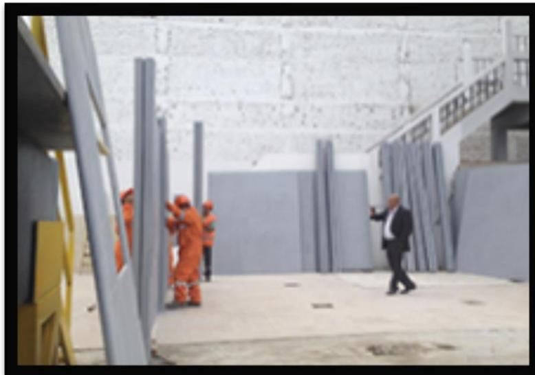
*Figura 9:* Placas de concreto polimérico
