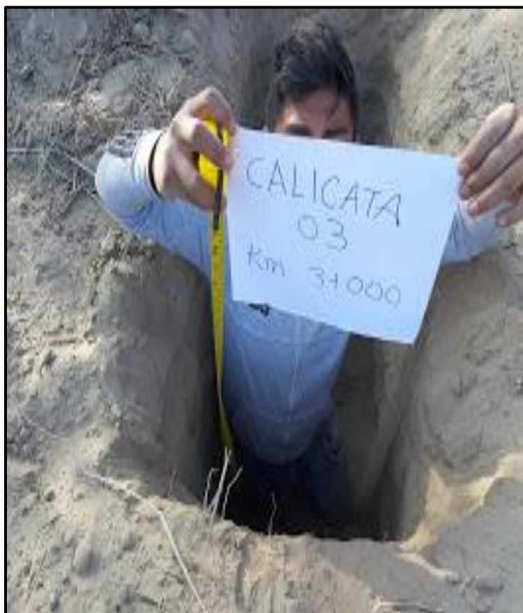
Figura 6 excavación de calicatas. Fuente: Elaboración propia.
