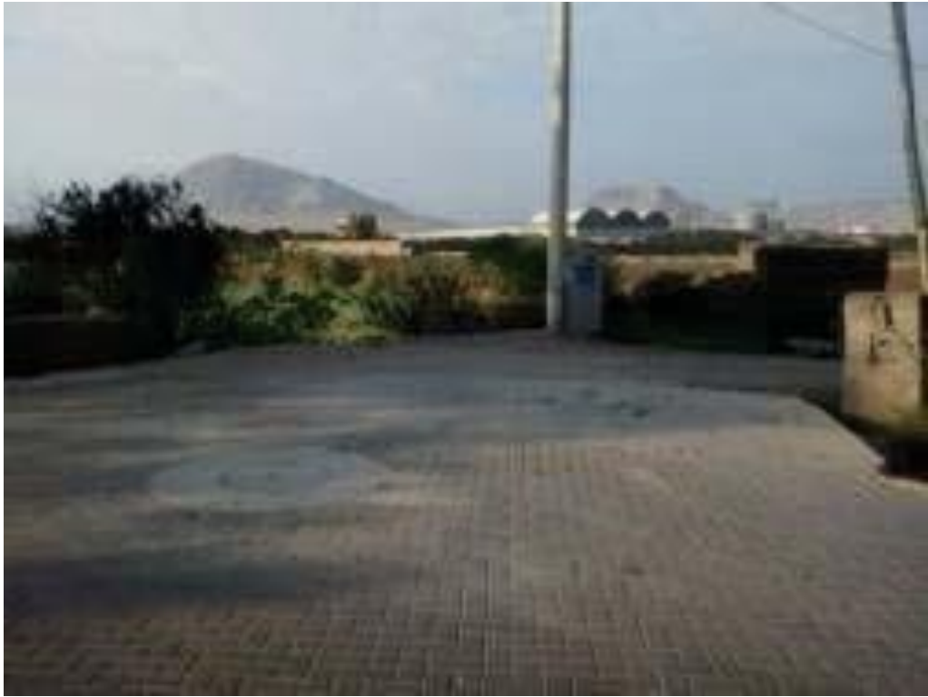
Ilustración 12 - foto de buzón de desagüe. fuente:propia
