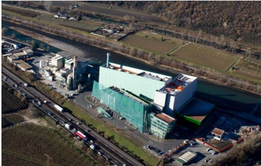
Figura 37: Planta de tratamiento "de desechos a energía" en Bolzano,
