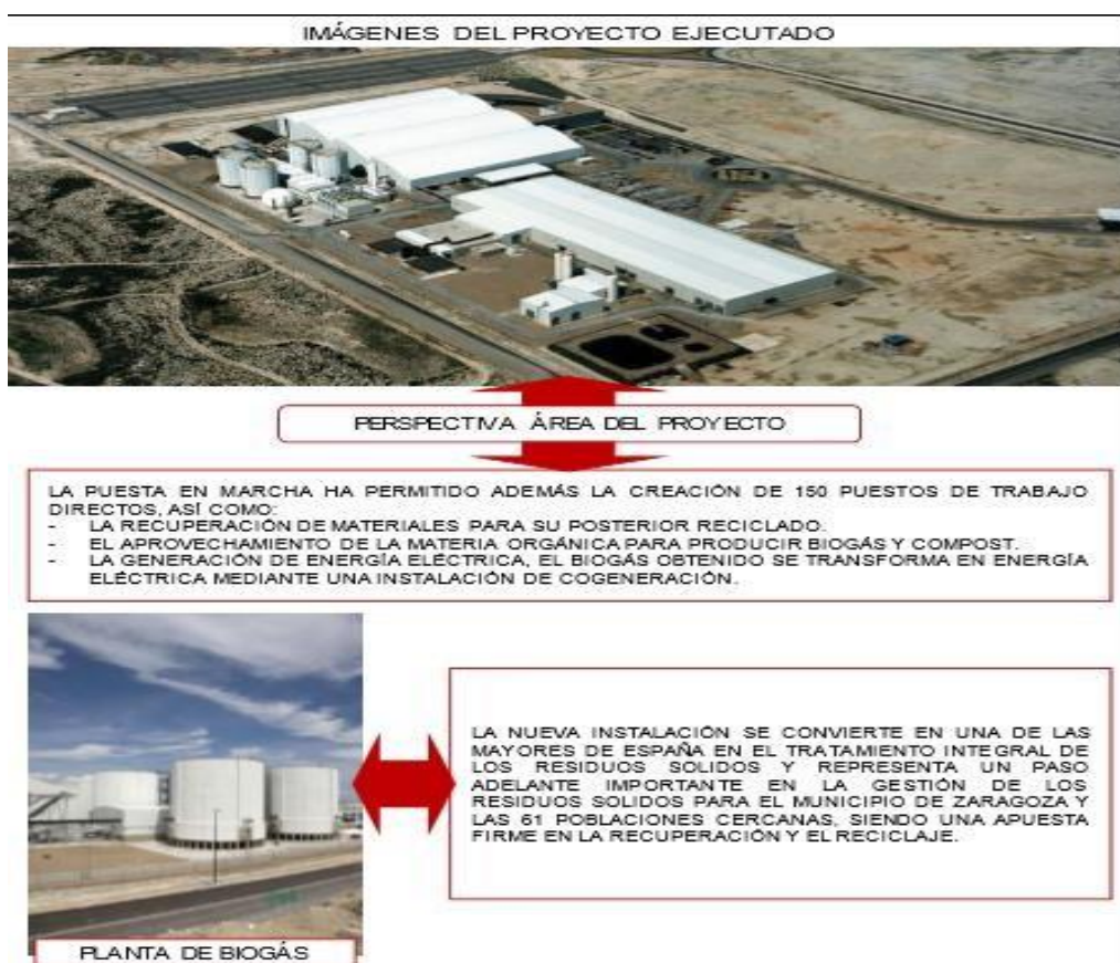
Figura 32: proyecto: Complejo para tratamiento de residuos urbanos de Zaragoza ejecutado. Fuente propia. Este complejo de tratamiento cuenta con una adecuada zonificación que enmarca cada espacio determinado de este proyecto, siendo así que no existe una saturación o cruce de ambientes.
