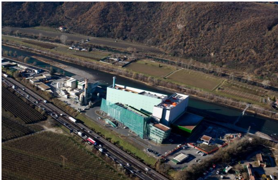
Figura 38: Planta de tratamiento "de desechos a energía" en Bolzano, Italia
