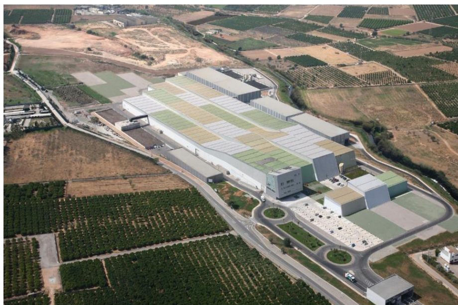
Figura 34: planta de tratamiento de residuos (PTR) Valencia.
