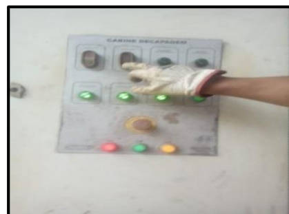
Figura 4. Preparación de cabina
