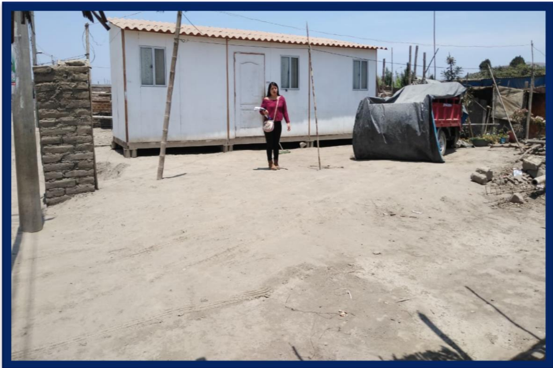
FIGURA N°05 Y N°06: SE PRESENCIÓ LA INSTALACIÓN DE UNAS VIVIENDAS PROVISIONALES OTORGADAS POR EL ESTADO
