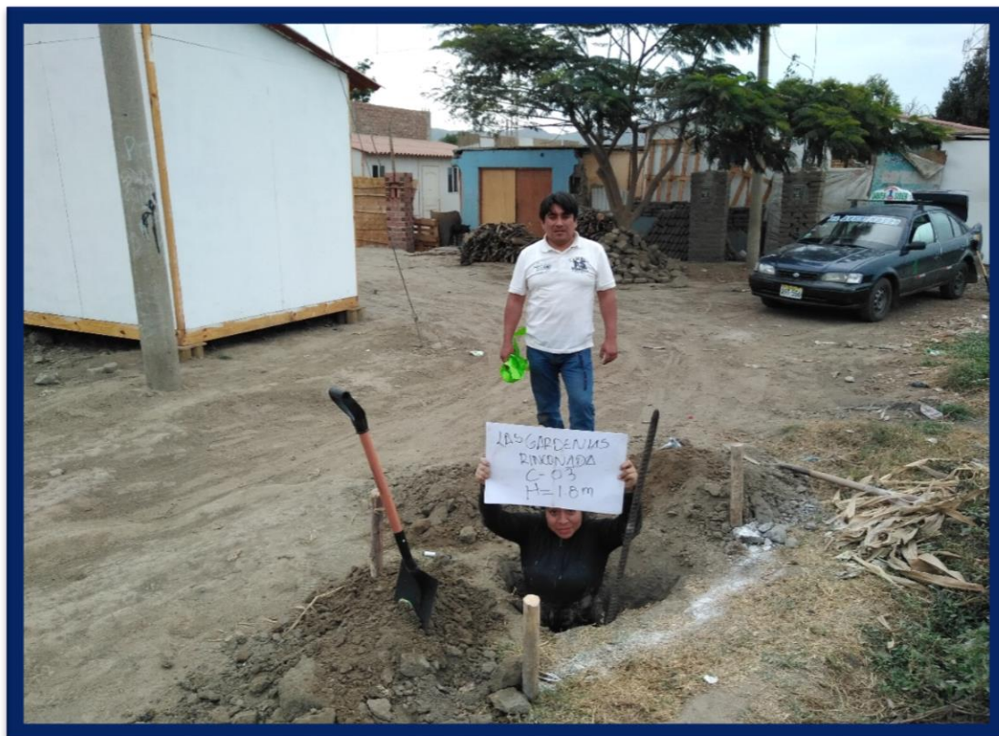
FIGURA N°07 Y 08: SE OBSERVA LA EXCAVACIÓN DE LAS MUESTRAS #02 Y #03, ESTAS TUVVIERON UNA PROFNDIDAD DE 1.80 M
