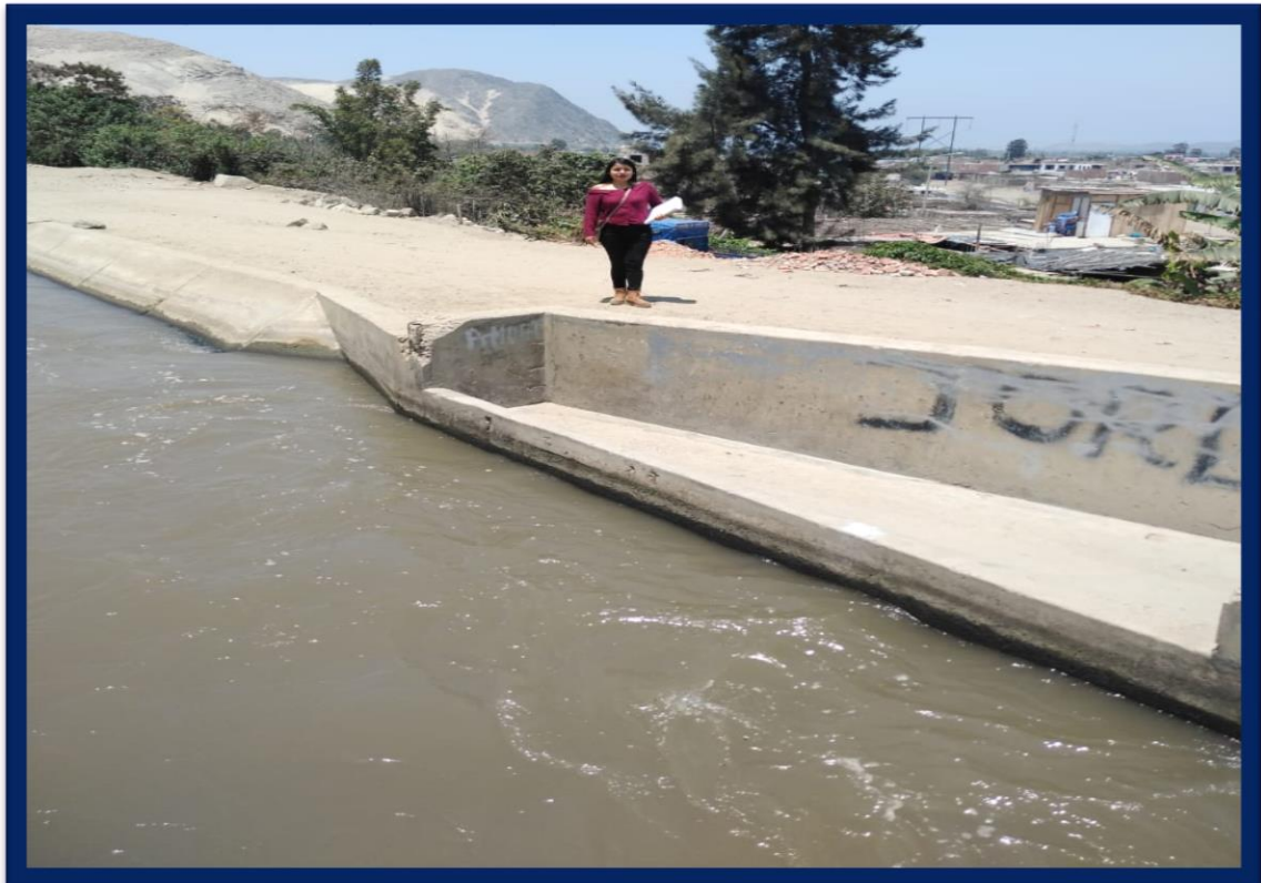
FIGURA N°03 Y N°04: EL CANAL IRCHIN FUE EL MAYOR CAUSANTE DEL LOS DAÑOS, DEBIDO A SU DESBORDE.
