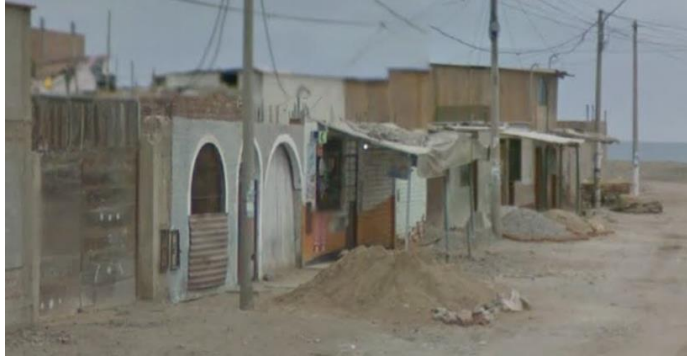
Figura 15. Ubicación de la vivienda en donde se implementará el sistema híbrido eólico-solar
