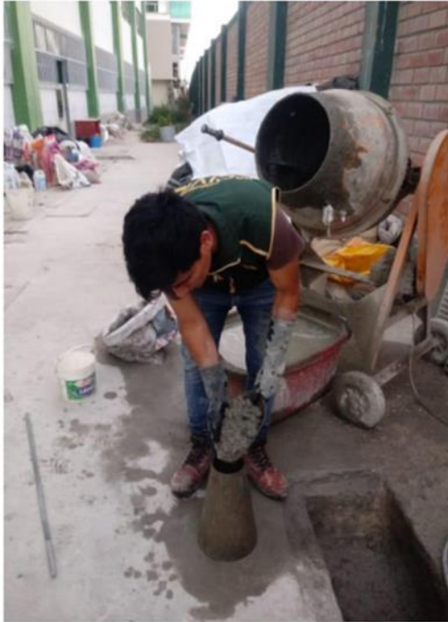
Imagen 9. Ensayo de consistencia del concreto.
