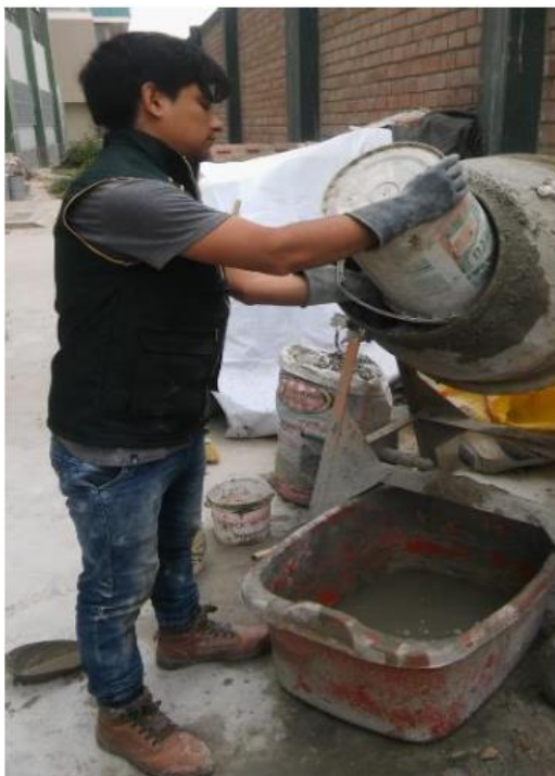
Imagen 7. Preparación de la mezcla del concreto.
