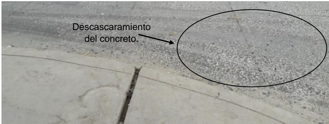
Figura 1. Cruce de la Av. Juan Velasco Alvarado con Av. Micaela Bastidas. Fuente: Elaboración propia.
