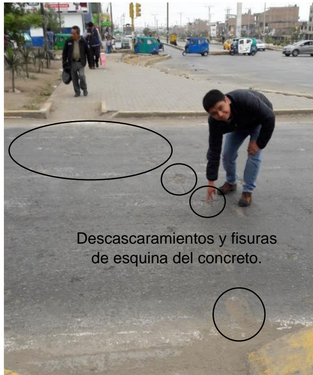
Figura 3. Cruce de la Av. Juan Velasco Alvarado con Av. Mariano Pastor Sevilla. Fuente: Elaboración propia.
