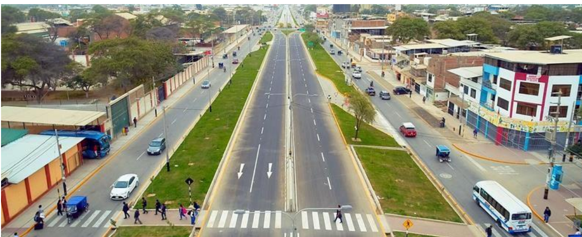
Figura 4. Av. Sánchez Cerro – Piura (obra por impuesto).
