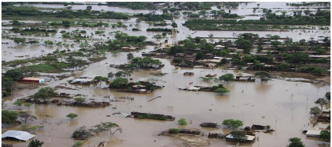
Figura 15: Vista panorámica del bajo Piura, inundado tras el desborde del Rio Piura
