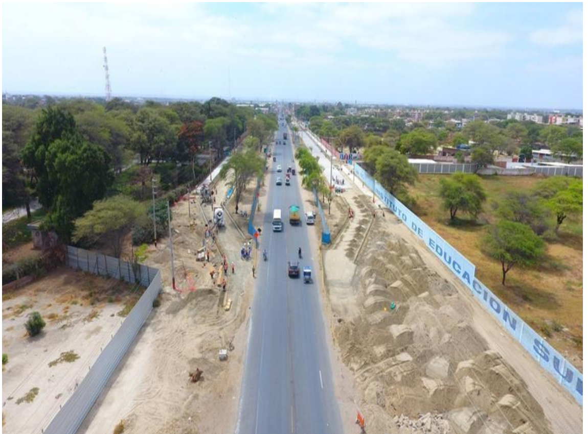
Figura 21: Av. Grau - Construcción anillo vial a través de obras por impuestos
