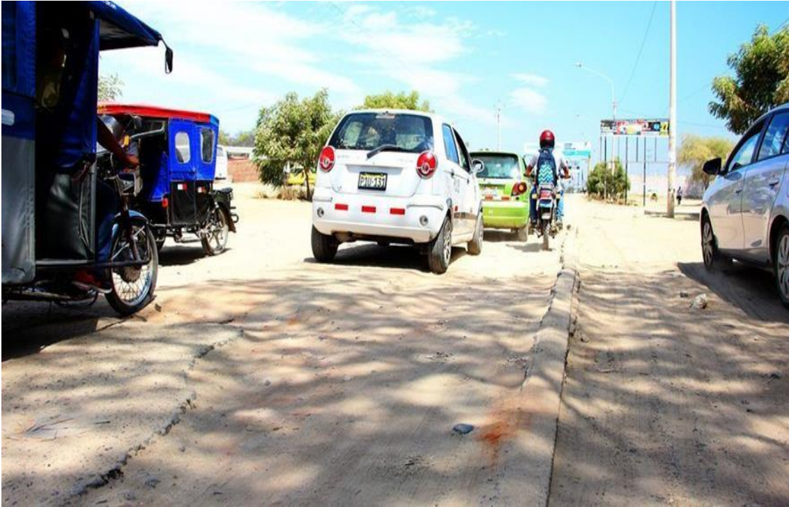
Figura 12: Av. Cáceres frente a la Universidad Cesar Vallejo – Distrito de Veintiséis de Octubre – Piura
