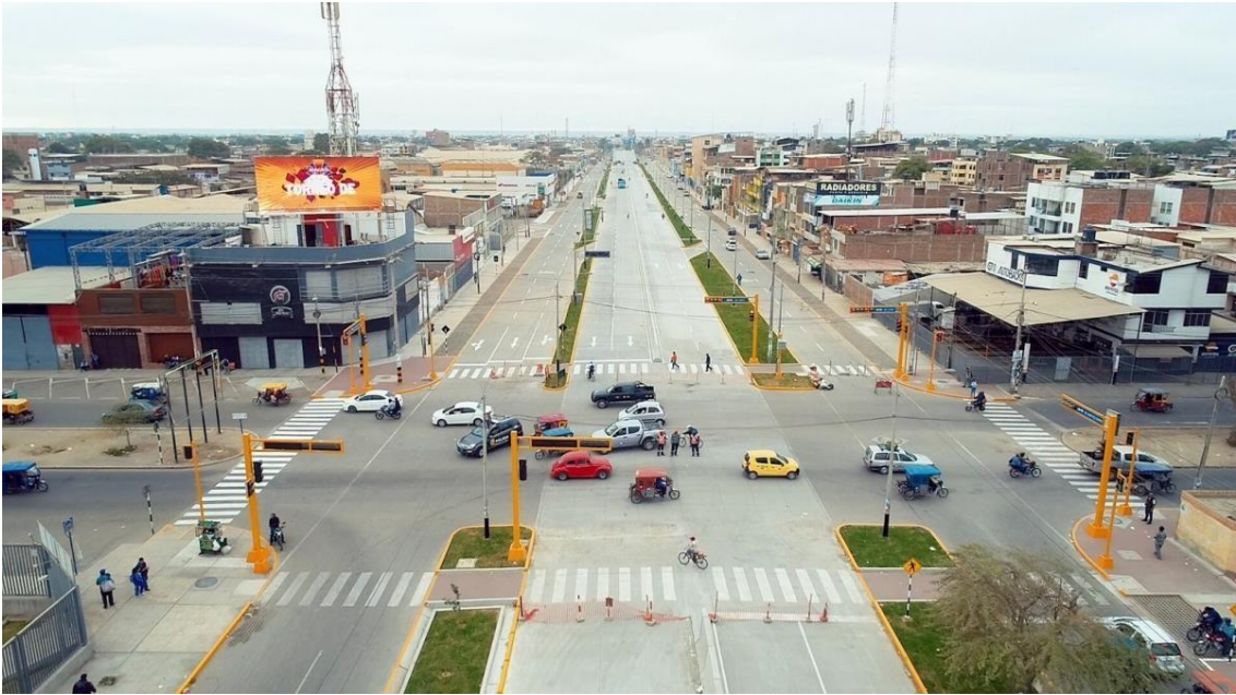
Figura 3. Vista panorámica de la Av. Sanchez Cerro – obra emblemática de Piura ejecutada a través de obras por impuestos.
