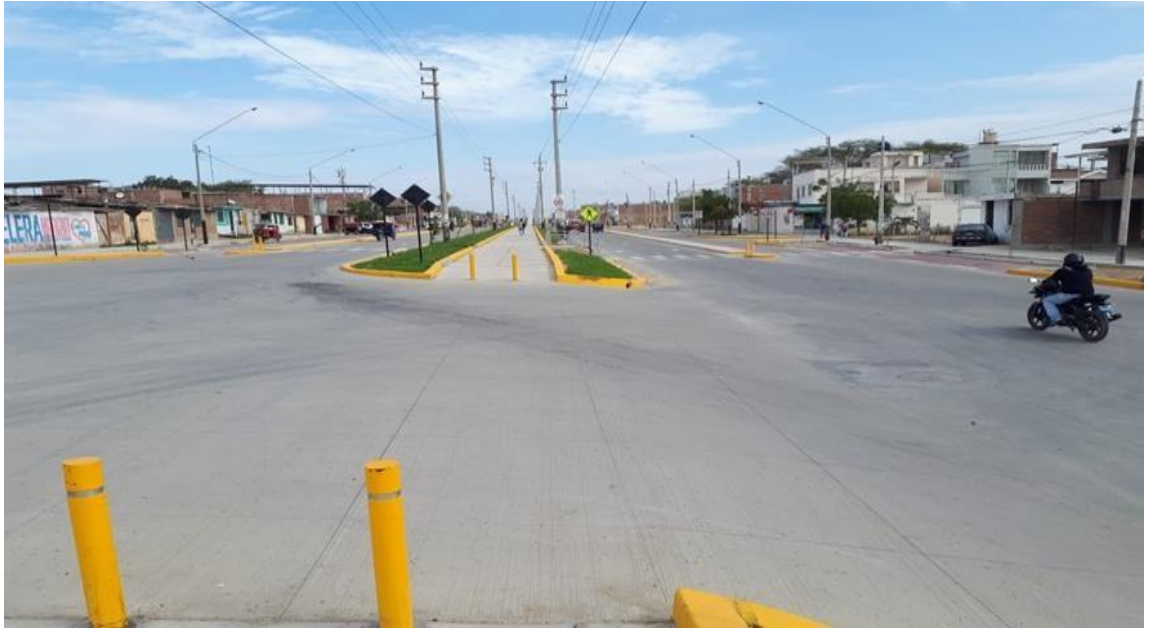
Figura 20: Obras por impuestos (pistas y veredas)– Distrito de Veintiséis de Octubre - Piura
