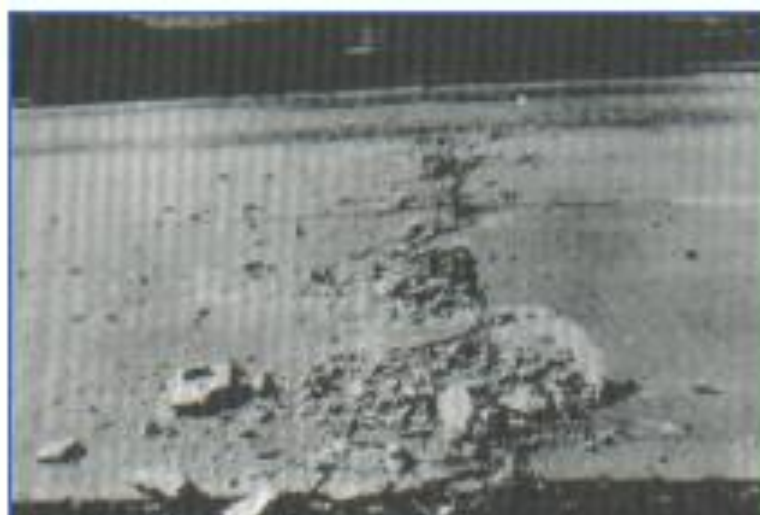
Ilustración 2. Blow up-Buckling
