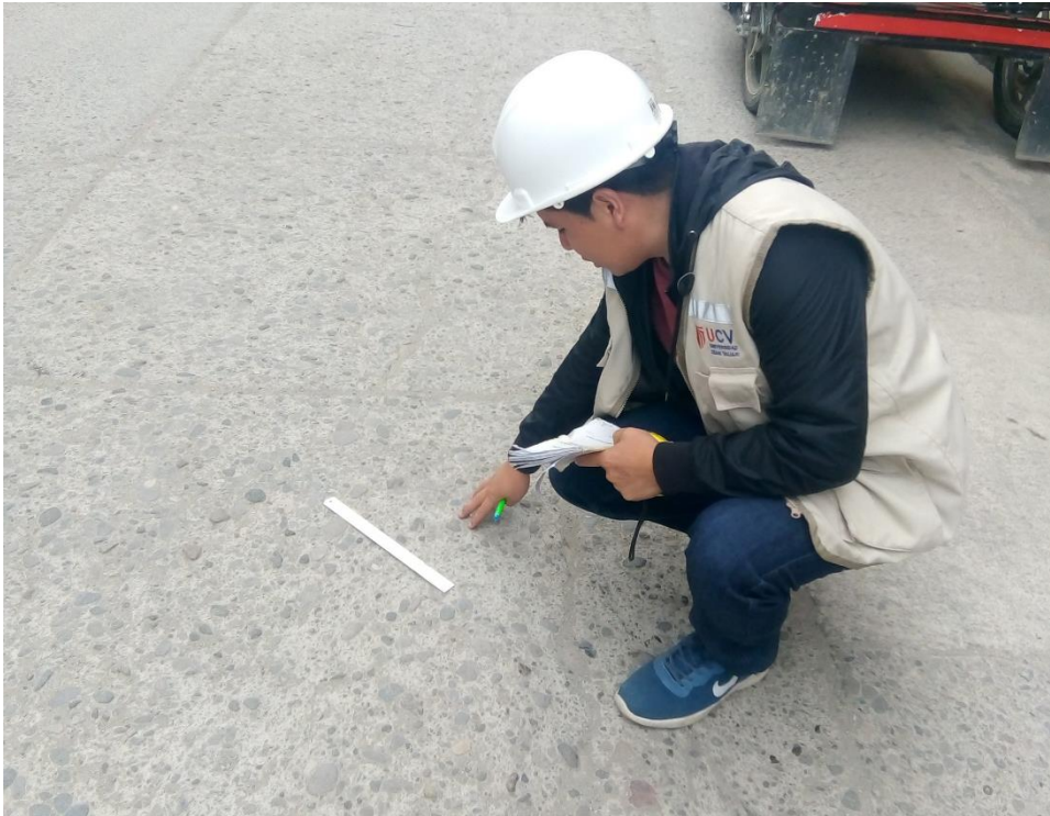
IMAGEN 11: En esta losa la falla que afecta es el pulimiento de agregados la cual no tiene un grado de severidad.
