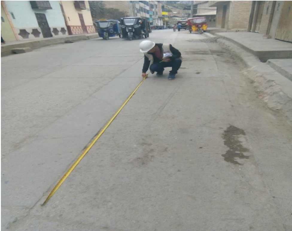
IMAGEN 12: En la imagen se observa el parche grande que presenta una severidad baja.
