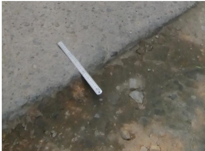
Ilustración 6: Falla escala
