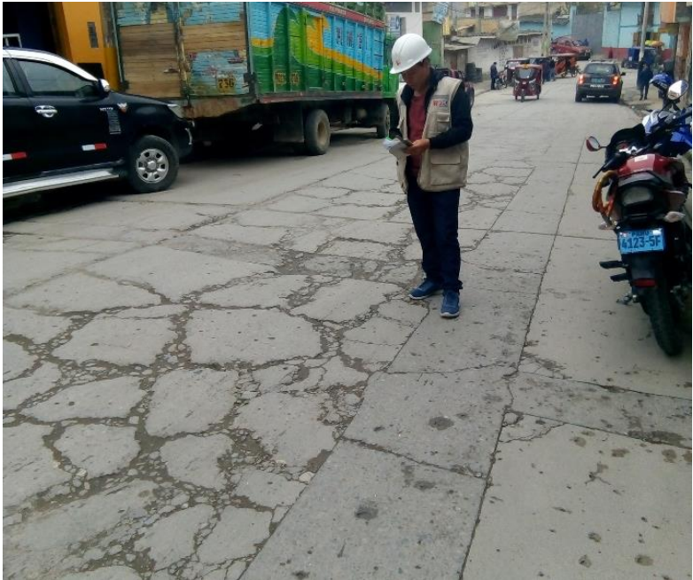
IMAGEN 6: En esta imagen se muestra el parche grande, además de punzonamiento de severidad alta ya que la losa tiene más de 5 pedazos de concreto.
