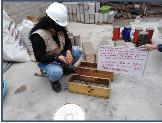
Imagen N° 14: Realización de vigas F'c=280 Kg/cm 2 (Patrón)
