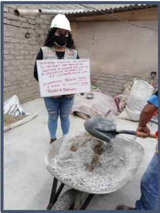
Imagen N° 09: Realización de mezcla de concreto F'c=280 \text{ Kg/cm}^2 (Patrón)
