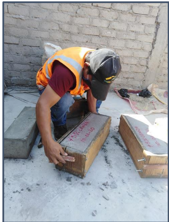
Imagen N° 27: Desencofrado de vigas de concreto experimental – sustitución 5% CCA.
