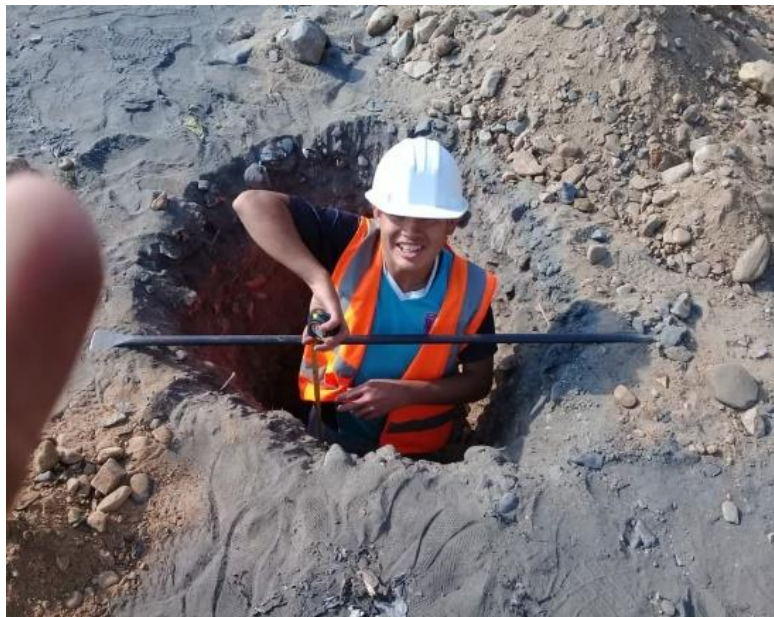
Figura: excavación de calicatas a la profundidad 1.50
