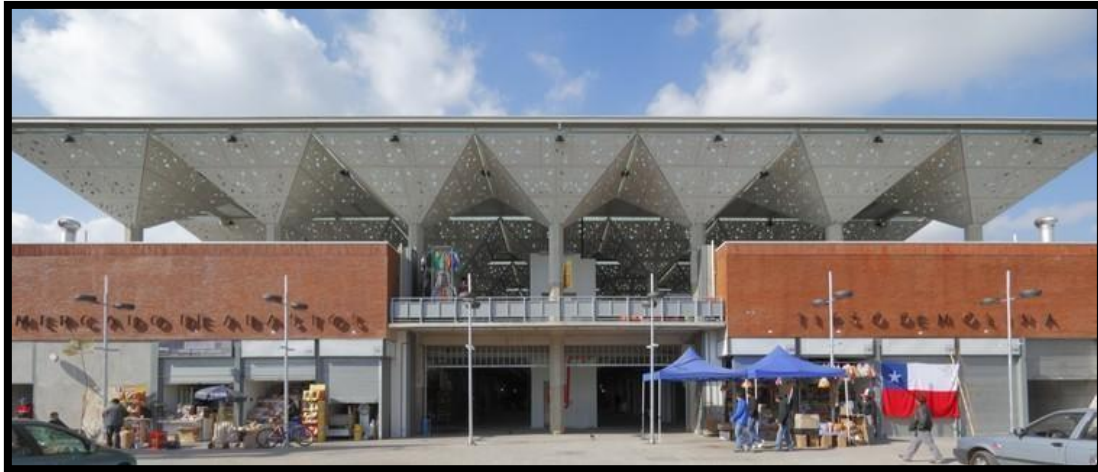
Figura 1: Fachada Principal del Mercado Tirso de Molina, fuente Archdaily.
