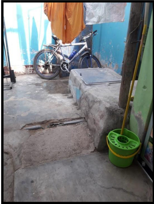
Foto 23 Instalación de agua
