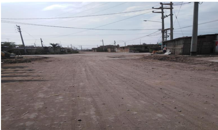
Figura 15: Culminación de levantamiento topográfico en intersección de calle N° 31 Y 10.
