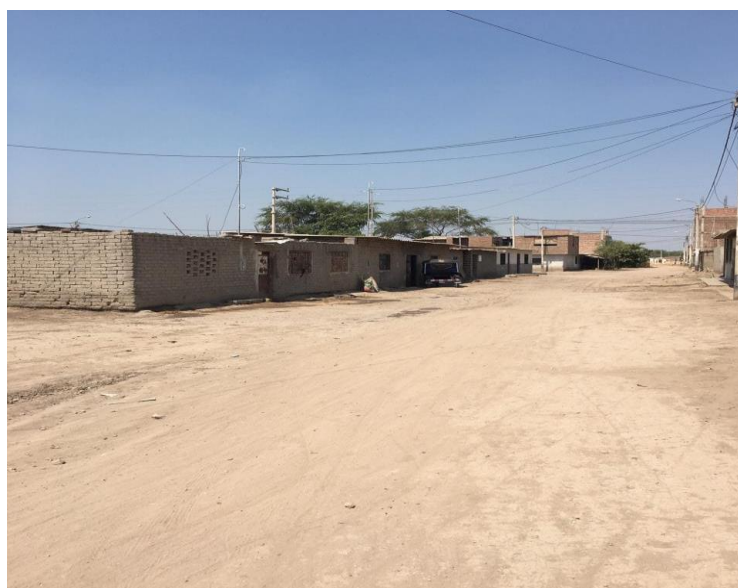
Figura 8: Estado actual en el que se encuentran las vías del Sector Pampa El Toro (Calle N° 16)
