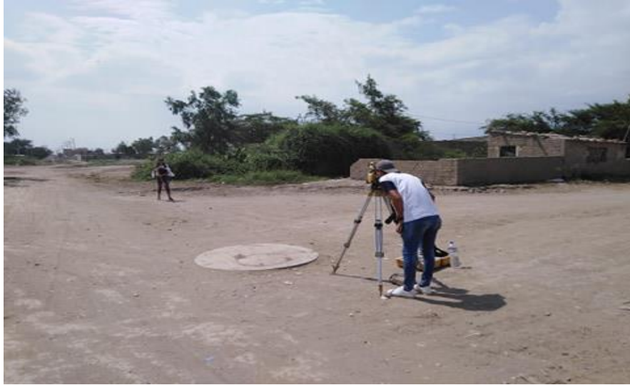
Figura 13: Trabajo de campo, levantamiento topográfico entre las calles N° 31 y N° 20.
