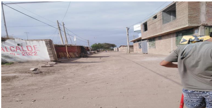
Figura 14: Trabajo de campo, levantamiento topográfico entre las calles N° 18 y N° 31.
