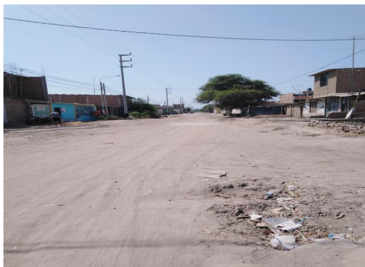
Figura 7: Estado actual de las vías del Sector Pampa El Toro (Calle N° 31).
