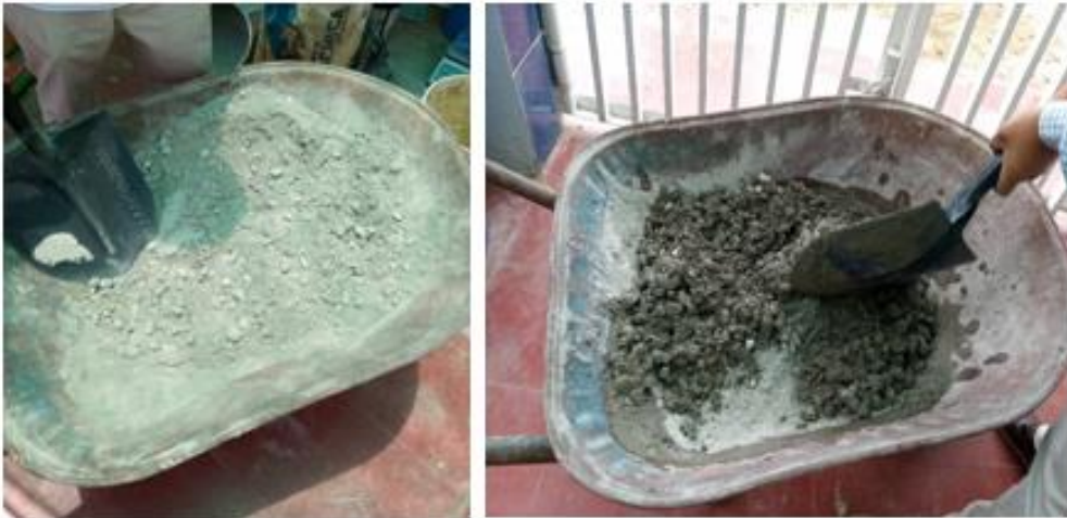
Figura 7: Mezclado de los materiales.
