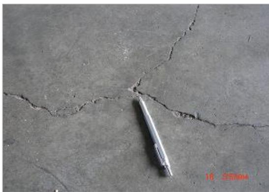
Figura 1. Fisuras en losas rígidas
