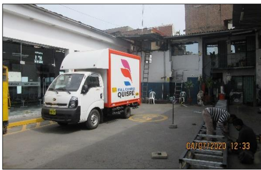
Figura 28. Instalación interior muy estrecha, se observa que no pueden realizar giros, los Ómnibus ingresan de retroceso.
