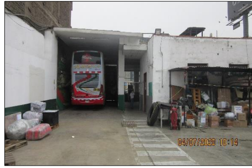
Figura 18. Instalación interior, donde se observa que los ómnibus ingresan de retroceso, tiene una sola entrada.
