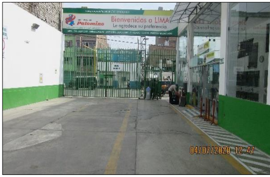
Figura 29. Terminal terrestre empresa de Transporte Expreso Internacional Palomino SAC, ubicado en Jr. Luna Pizarro 343-353-359, se observa una sola puerta ingreso y congestión vehicular.
