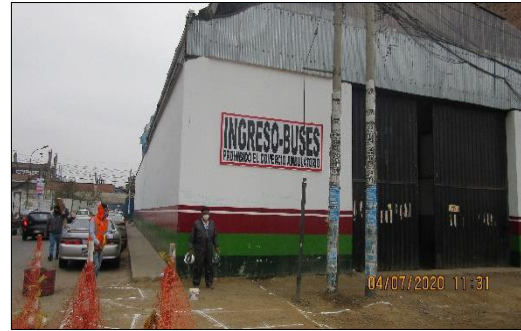
Figura 24. Ingreso de ómnibus por el Pasaje Cabo Alarcón 176 muy estrecho, que no pueden realizar giros, observándose sus instalaciones internas reducidas.
