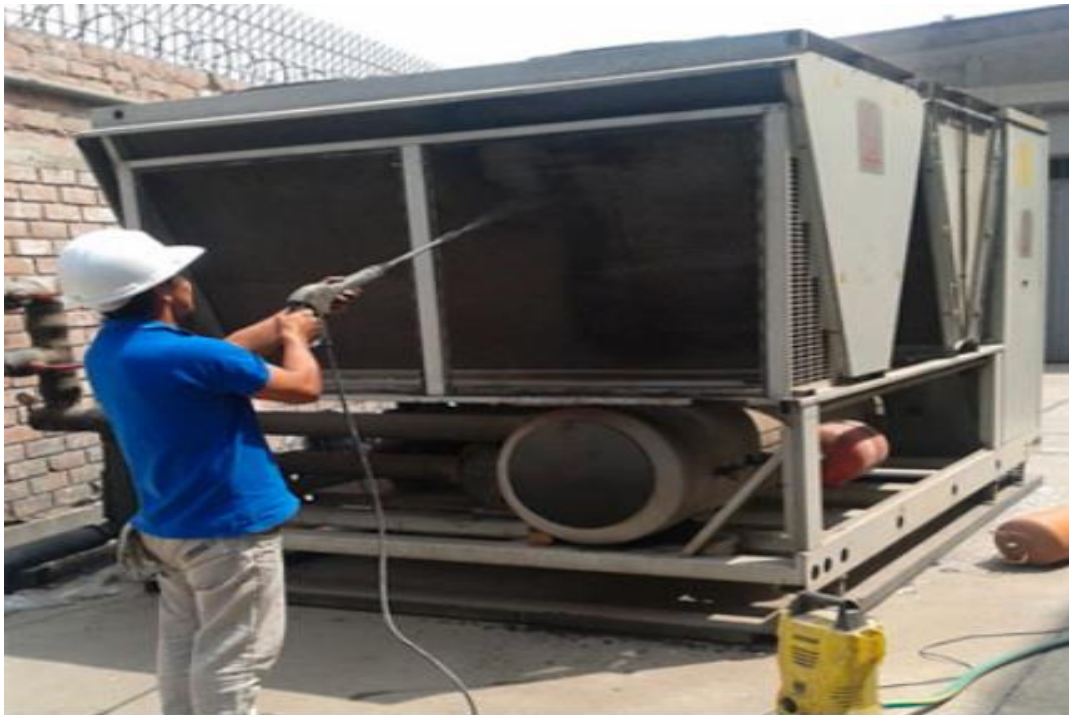
Anexo 3 Personal realizando actividades de limpieza
