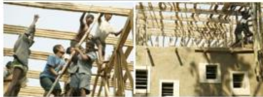
PROCESO CONSTRUCTIVO MUROS
