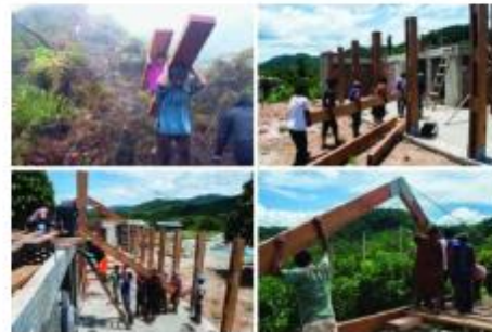
Imagen donde se puede observar la comunidad siendo participe de la construcción de la escuela
