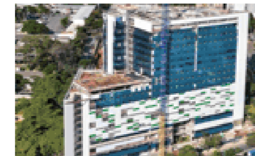
La Nueva Unidad Hospital Mater Dei, en Belo Horizonte
