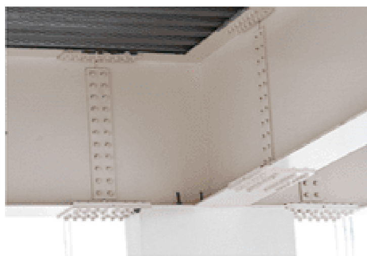
Fijación atornillada de la estructura metálica del Helipuerto agilidad en el montaje y permitió mejor tratamiento superficial contra corrosión.
