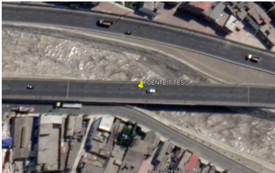
Figura 11 Ubicación satelital de Puente 7
