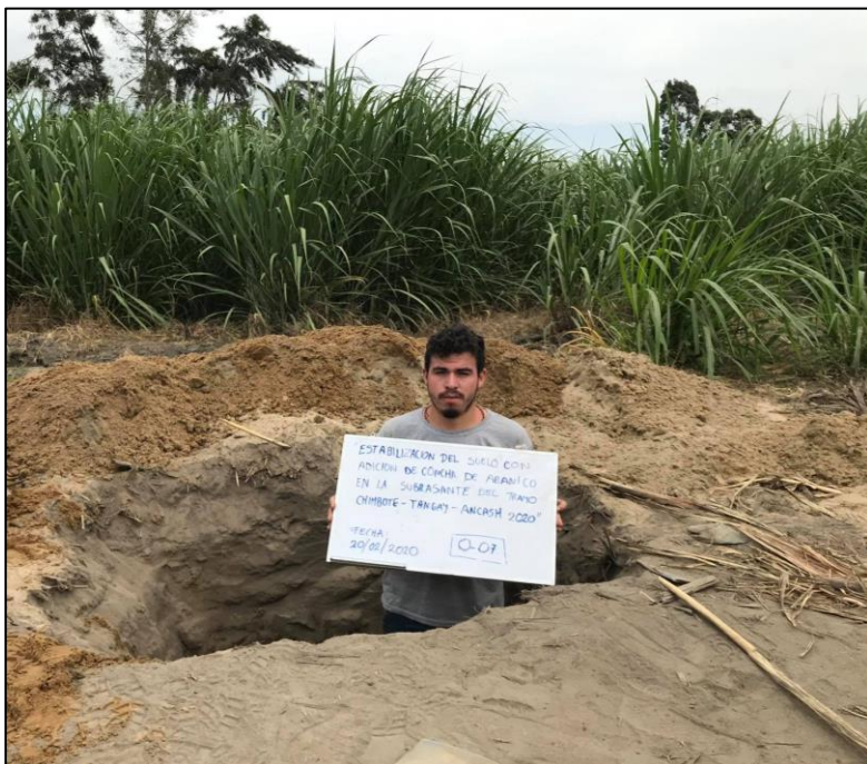
FOTO N° 11: SE OBSERVA LA EXCAVACION DE LA CALICATA N° C-07.
