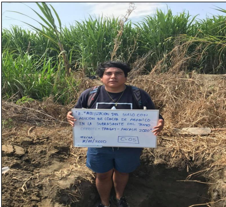
FOTO N° 09: SE OBSERVA LA EXCAVACIÓN DE LA CALICATA N° C-05.
