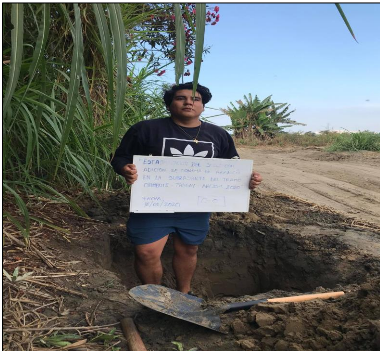
FOTO N° 08: SE OBSERVA LA EXCAVACIÓN DE LA CALICATA N° C-04.
