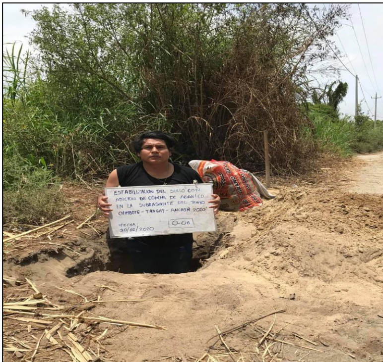
FOTO N° 10: SE OBSERVA LA EXCAVACIÓN DE LA CALICATA N° C-06.
