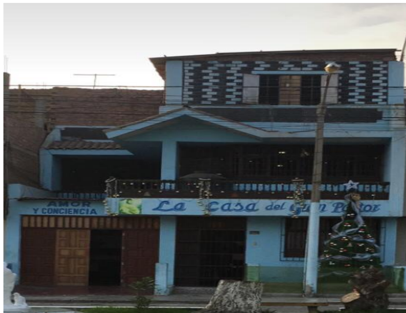
Figura 77: Centro de rehabilitación “La casa del buen pastor”. Fuente: elaboración propia.
