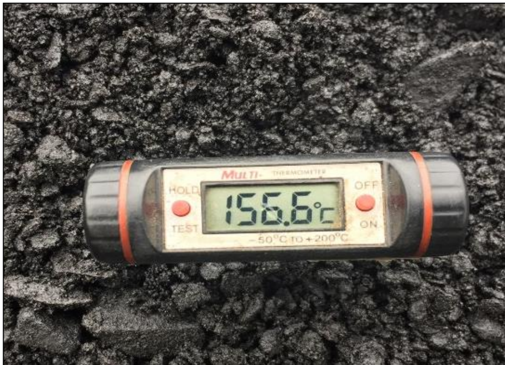
Foto 22: Proceso de pavimentación. Temperatura de colocación de mezcla
