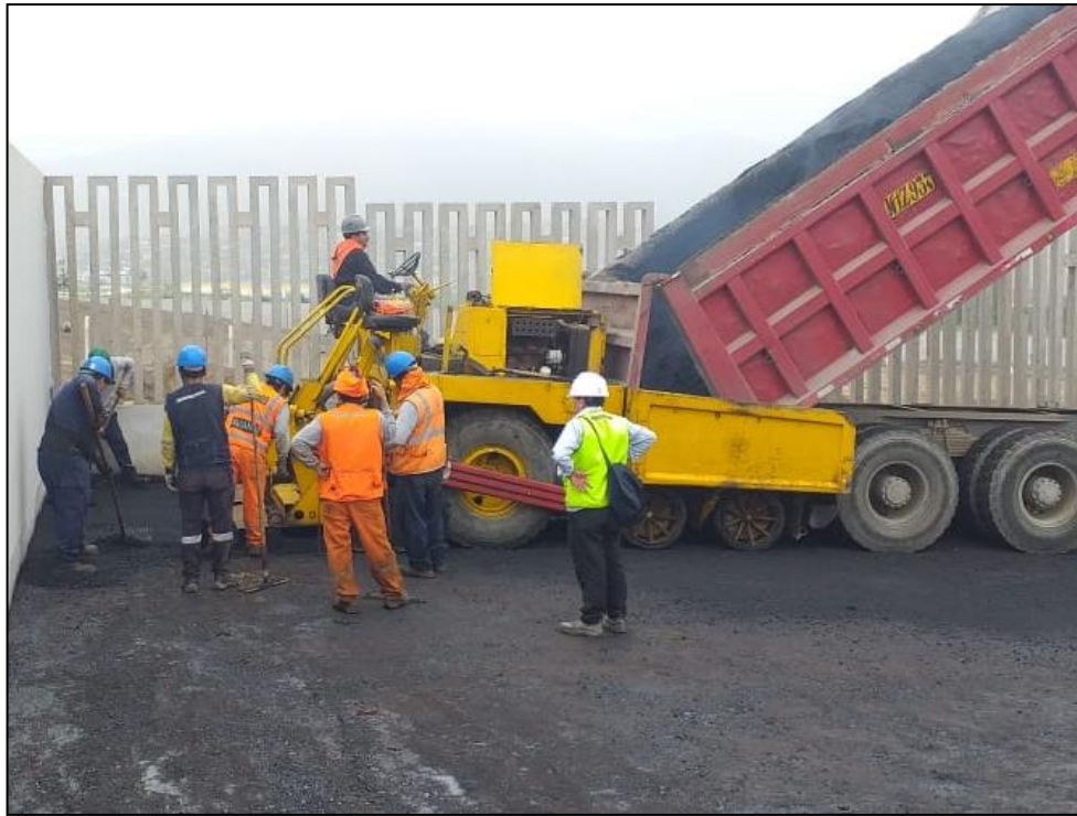
Foto 21: Proceso de pavimentación. Conformación de carpeta asfáltica
