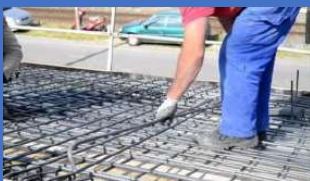
Construcción de una losa maciza Fuente: CLIPZUI
