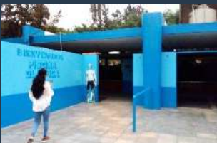
Ingreso a los vestuarios Fuente: Elaboración Propia
