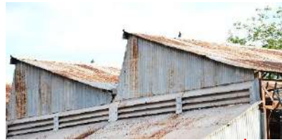
Cubierta antigua de la Nave creativa. Fuente: CAMZA 2017
