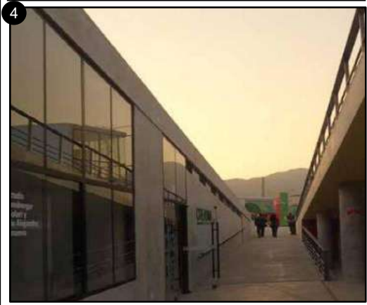
Rampa del CREA Huiracocha Fuente: ARKINKA
