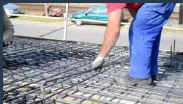
Construcción de una losa maciza Fuente: CLIPZUI
