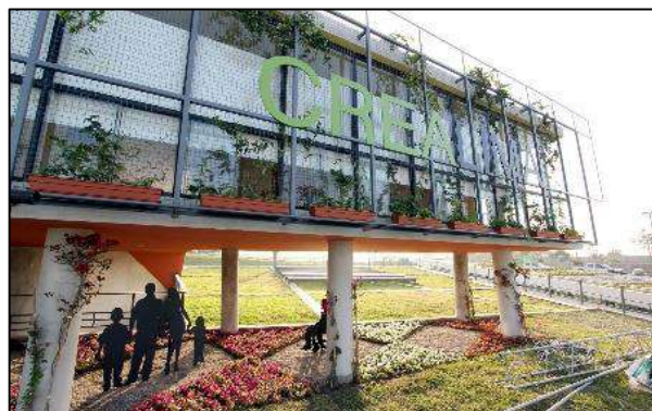
Fachada de estructura metálica. Fuente: Betinforma
