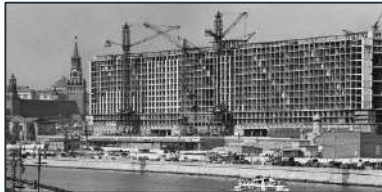
Construcción del Hotel Russiya Fuente: Meduza.io
