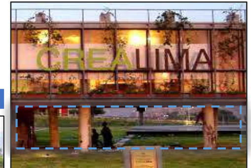
Fachada del CREA Fuente: Google Maps
