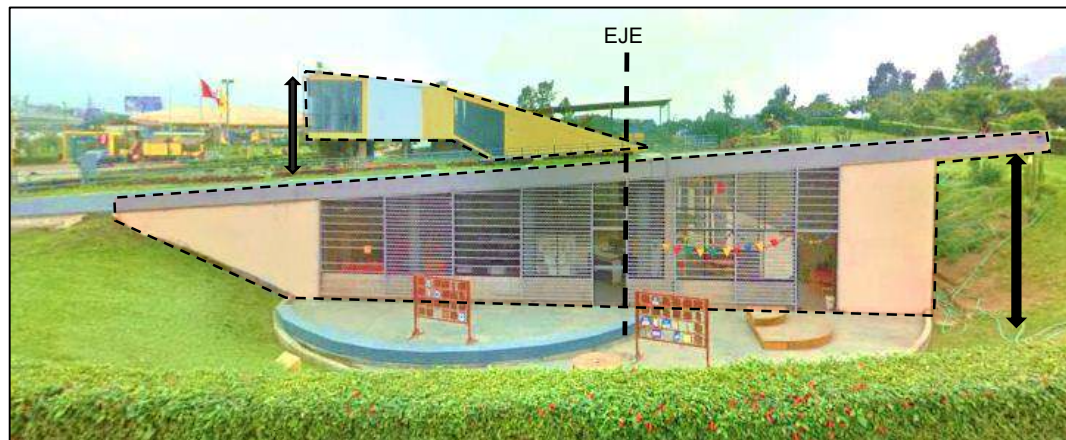
Fachada lateral del CREA Fuente: Google Maps
