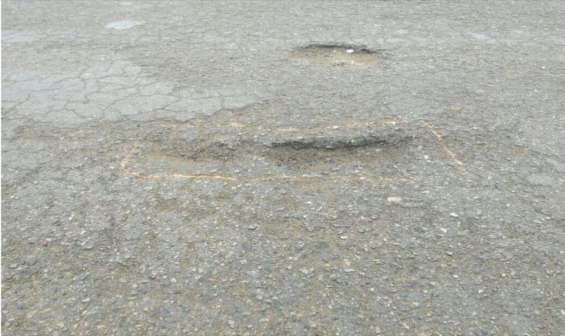
Se puede apreciar el estado actual de los pavimentos flexibles, el cual presenta fallas superficiales y estructurales debido a la falta de mantenimiento.
