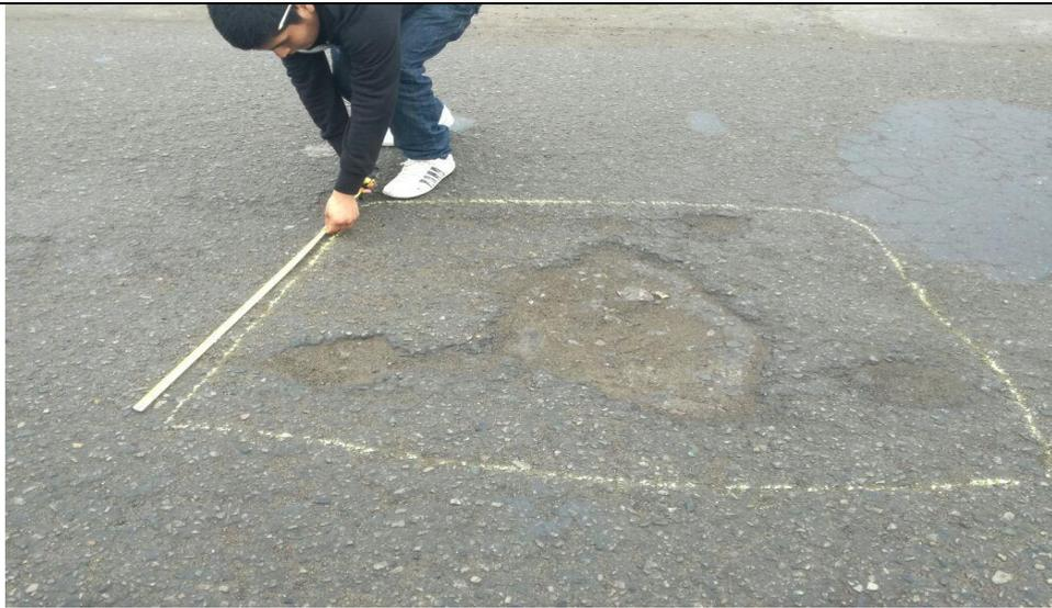
Se puede apreciar el estado actual de los pavimentos flexibles, el cual presenta fallas superficiales y estructurales debido a la falta de mantenimiento.
