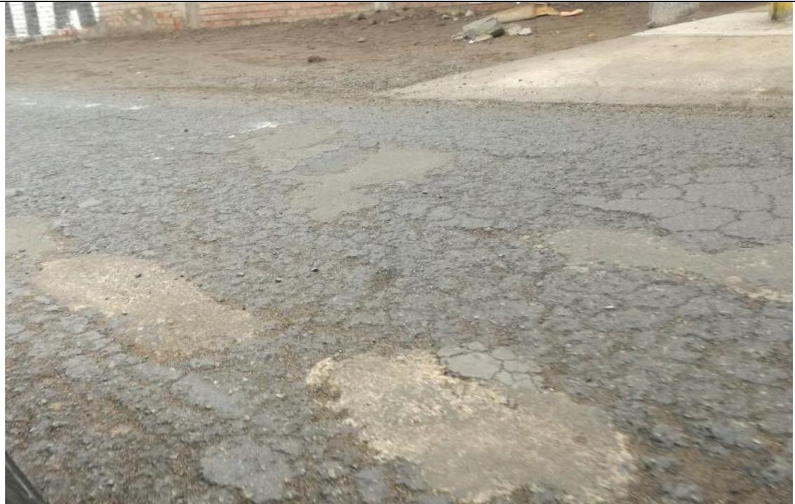
Se puede apreciar el estado actual de los pavimentos flexibles, el cual presenta fallas superficiales y estructurales debido a la falta de mantenimiento.
