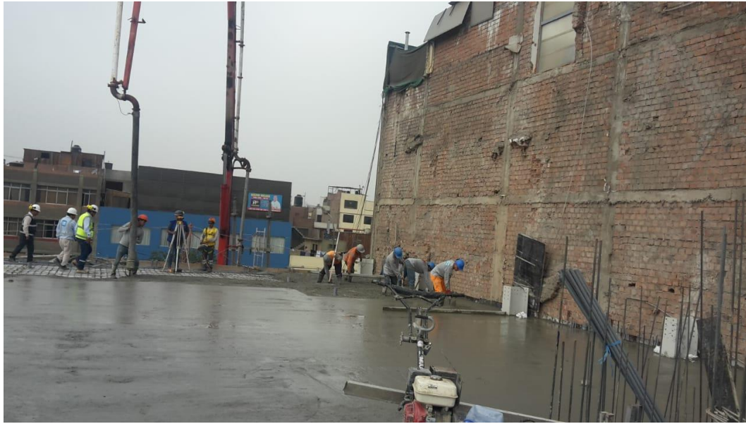
Verificación de la limpieza de la estructura
