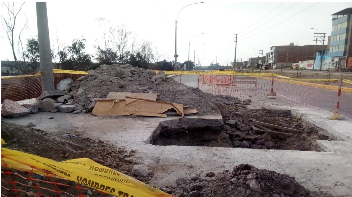
Panel fotográfico 2. Concreto reciclado procedente de cortes de pavimentos rígidos en la Av. Magisterio.
