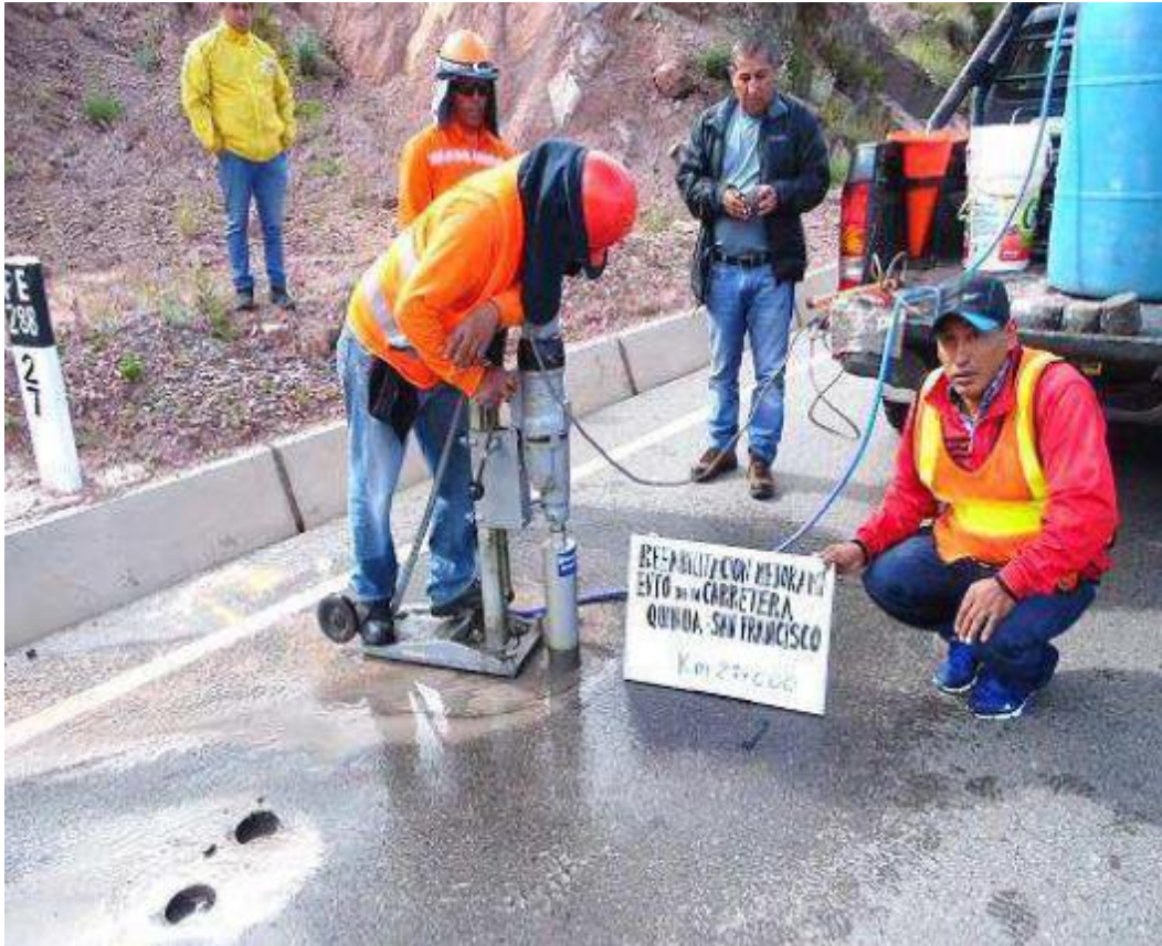
Figura 3. Toma de núcleos en pavimento rígido
