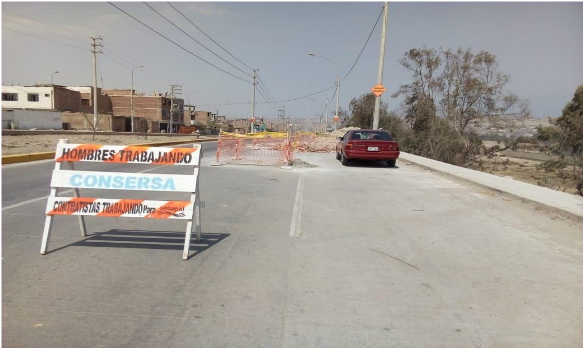
Panel fotográfico 1. Ubicación de material de concreto reciclado - Av. Magisterio
