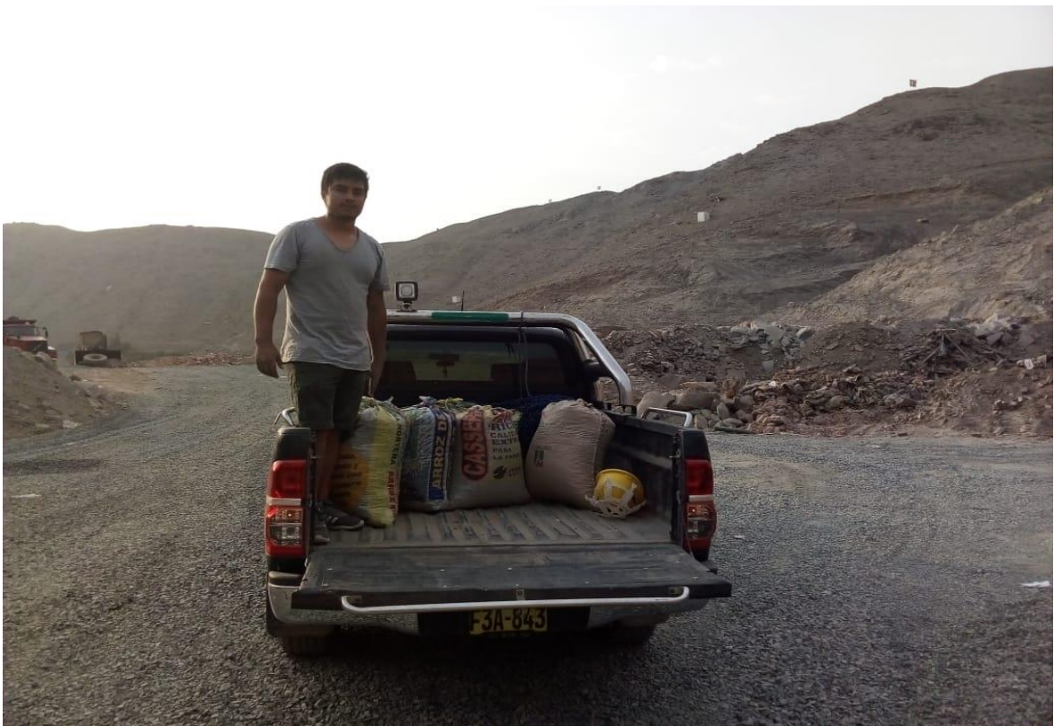
Panel fotográfico 4. Transporte de los agregados gruesos naturales en sacos de 50 kg.
