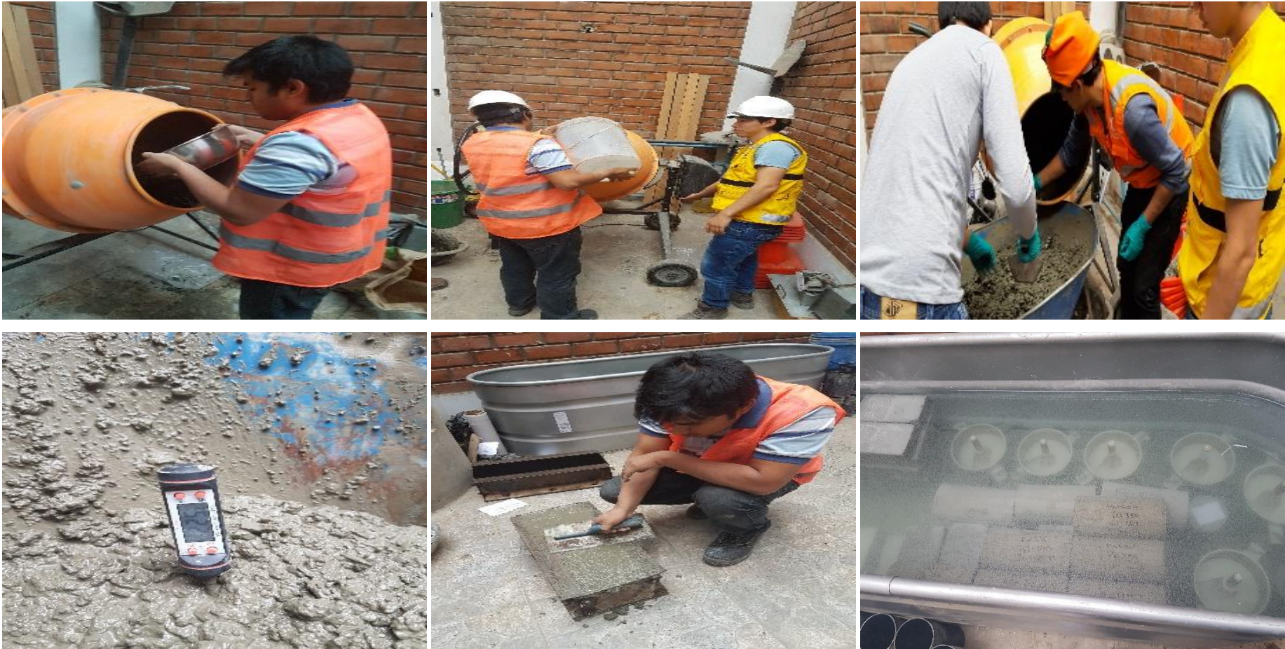
Panel fotográfico 26. Elaboración y curado de especímenes de concreto según la Normativa NTP 339.183, ASTM C 192
