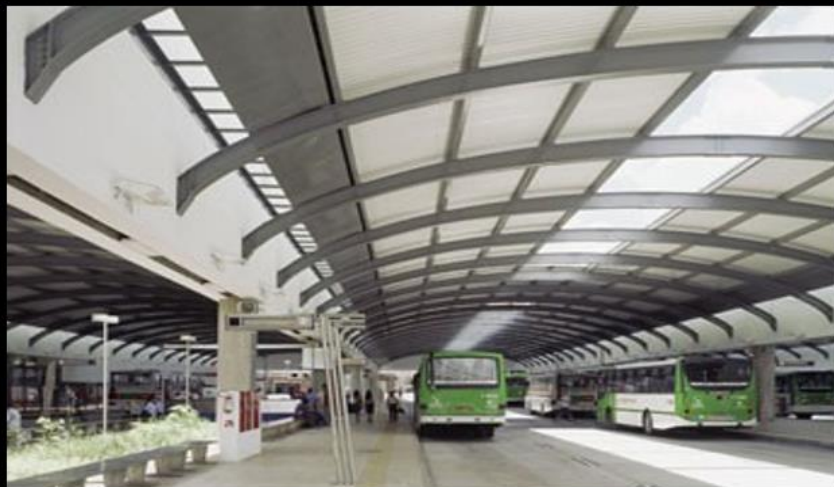
Punto de encuentro de estructura metálica y vigas
