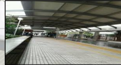
Estación Estación ferroviaria.
