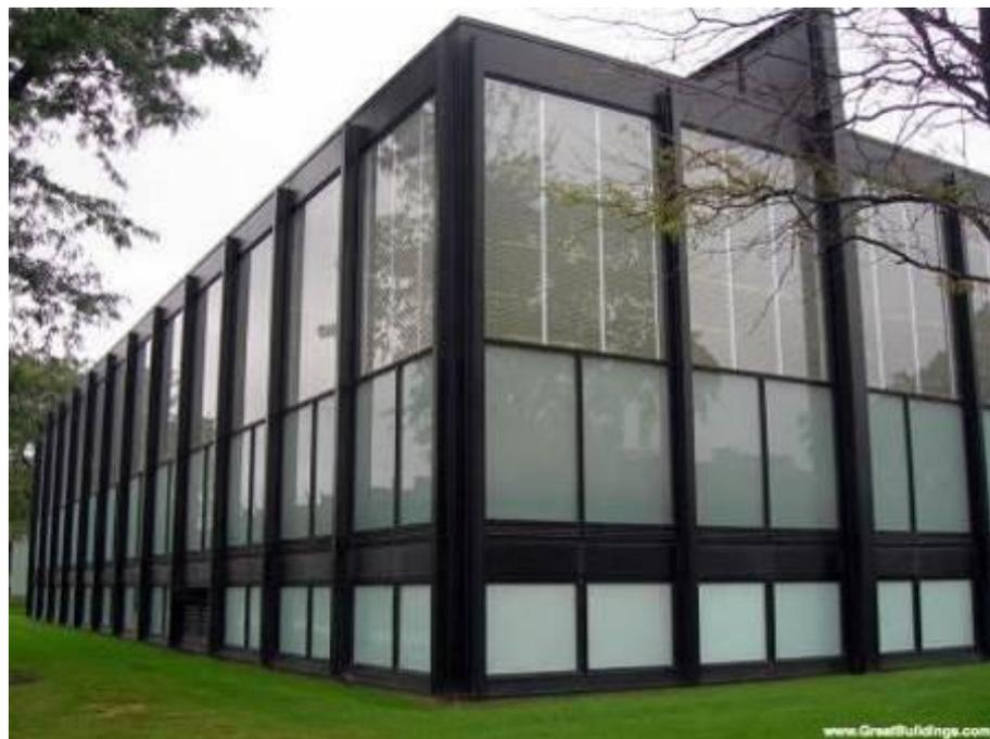
El edificio se encuentra compuesto en dos niveles: la primera planta y un nivel semi enterrado donde se ubican las oficinas, salones y servicios. El semi sótano se encuentra apoyado en un entramado de columnas de 6 x 9 metros.
