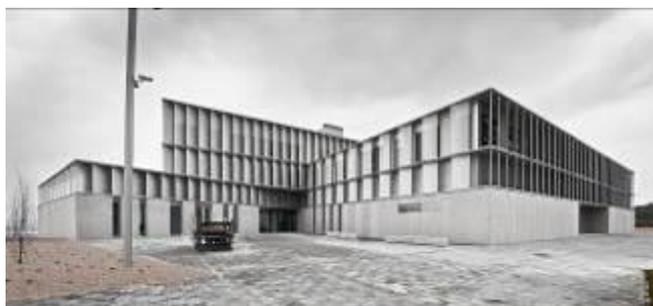
La planta baja, en cambio se diseñó como zócalo ciego de hormigón visto, los aleros de las plantas superiores varían sus dimensiones en función de la orientación del sol, para que se puedan adecuar a las necesidades de los ambientes interiores.
