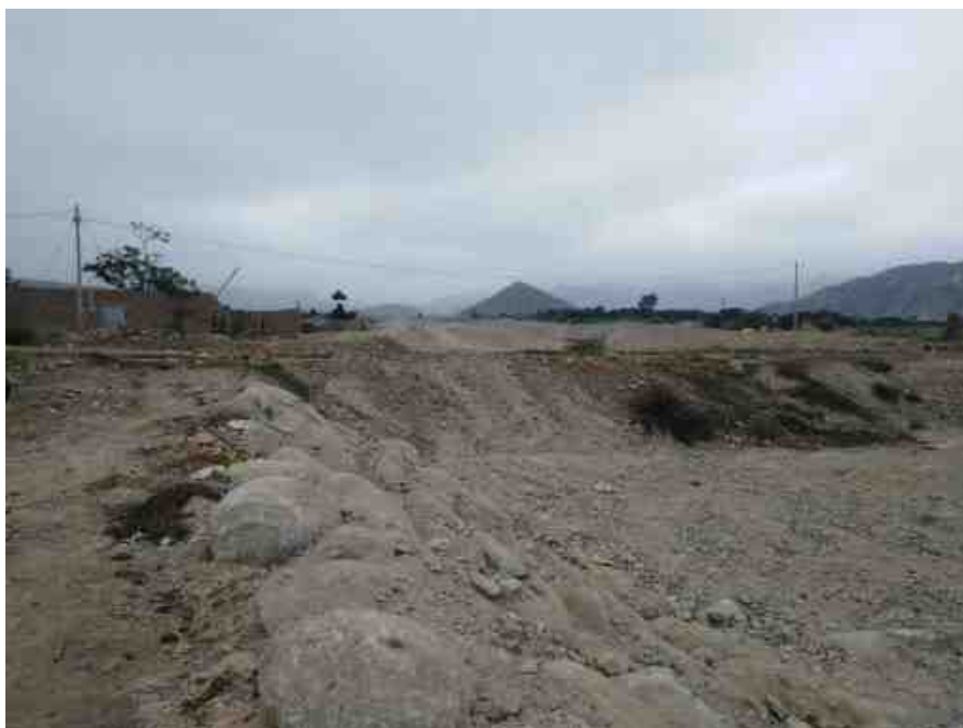
Foto N°4: Vista general de faja marginal y canales moro y incaica
