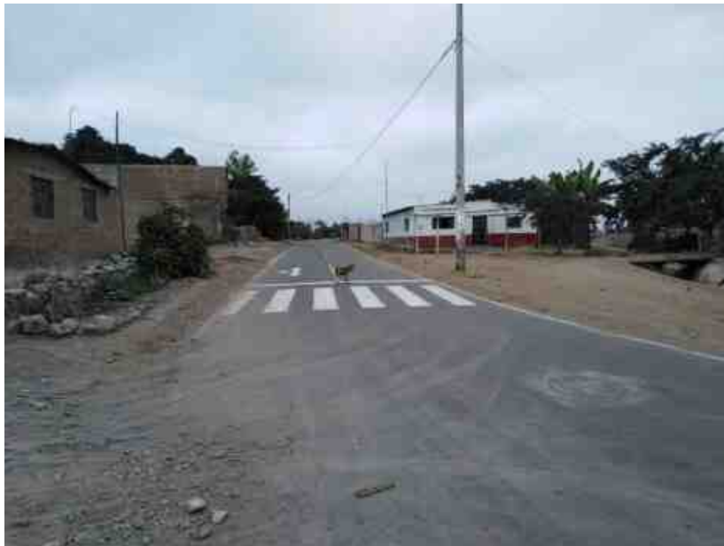
Descripción: Buzón recolector de alcantarillado, va al tanque imhoff.
