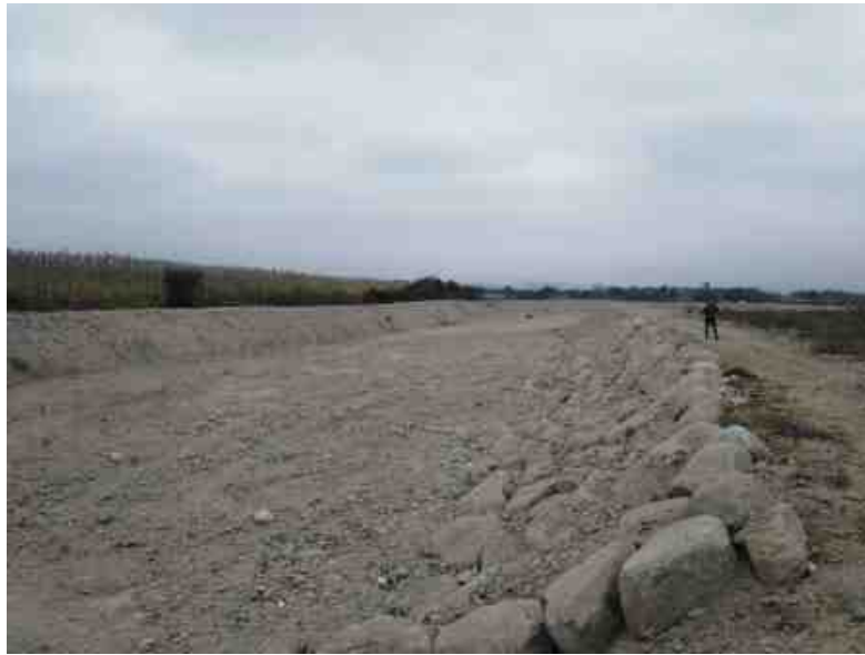
Foto N° 1: Faja marginal de quebrada San Carlos
