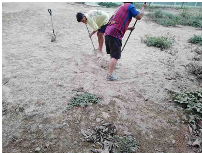
Foto N°10: Empezando calicata para tanque imhoff
