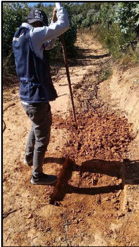
FOTO 09: Inicio de trabajos para calicatas
