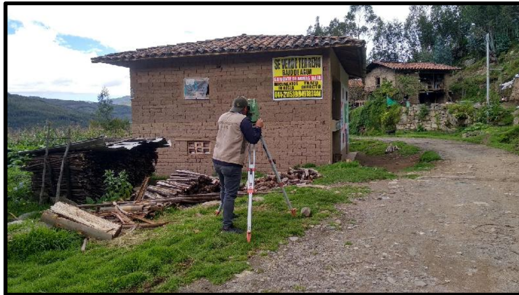
FOTO 08: Estudio topográfico para la toma de datos de la carretera existente.
