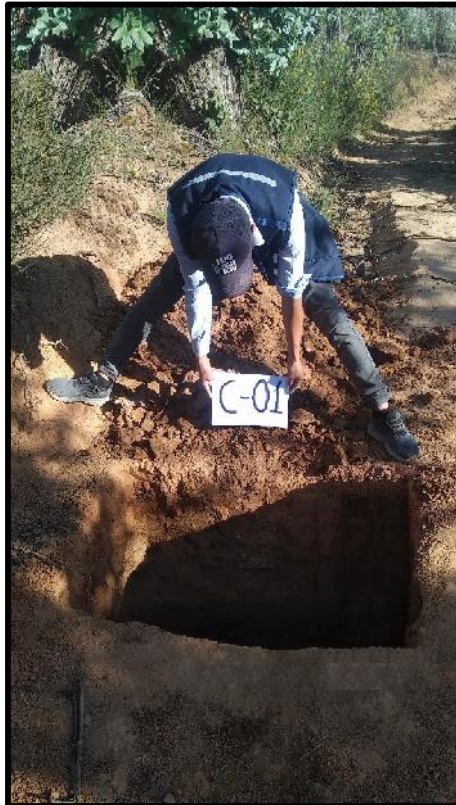
FOTO 09: Enumeración de calicata para identificar la muestra y llevar al laboratorio de mecánica de suelos.
